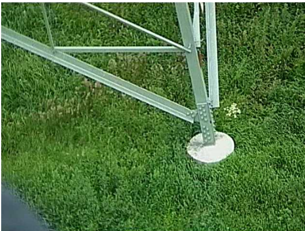
Obr.: Připojení konstrukce stožáru do základu
