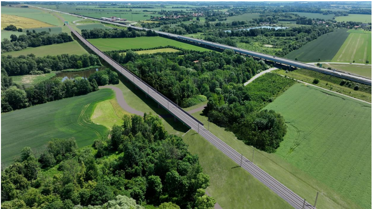
Obr. 111 Pohled na trať VRT, sjezdovou větev VRT v oblasti Oderských rybníků (rybník Cíp)
