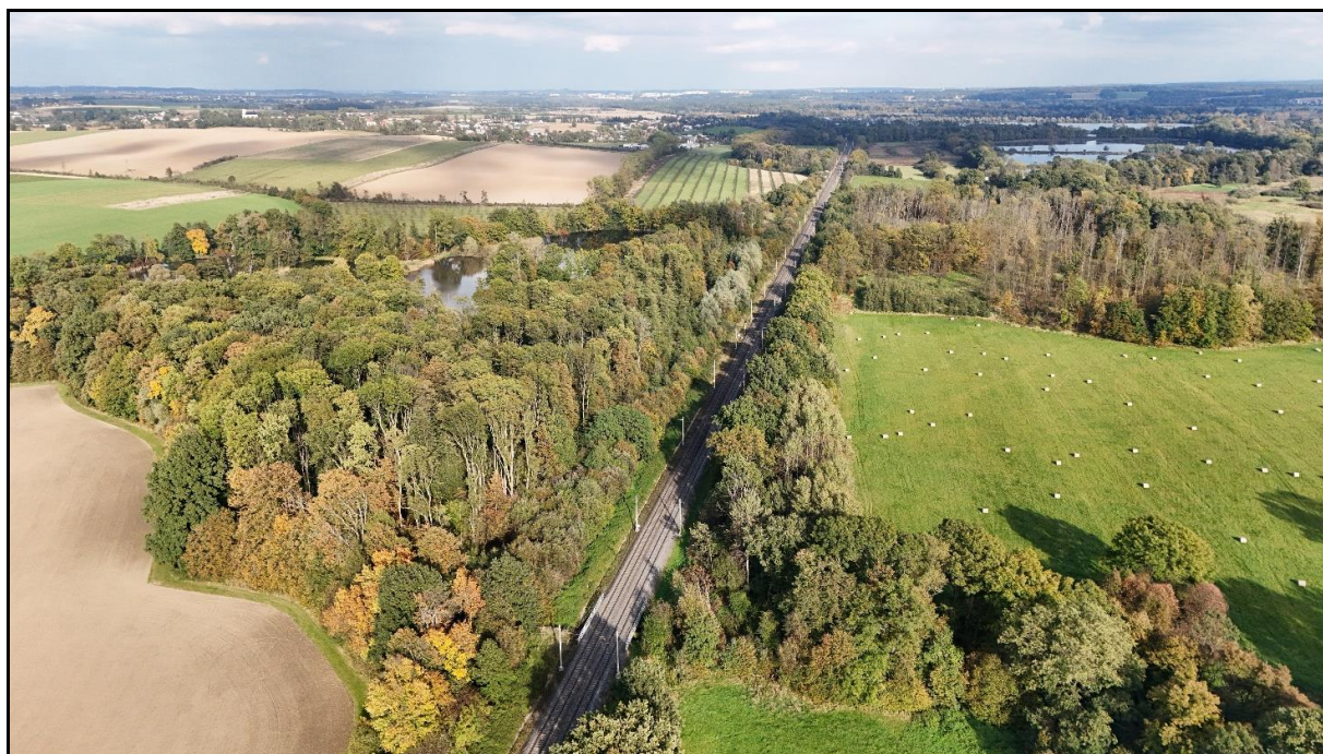
Obr. 101 Dotčený porost tvrdého luhu mezi železničním koridorem a rybníkem Velký Roh
