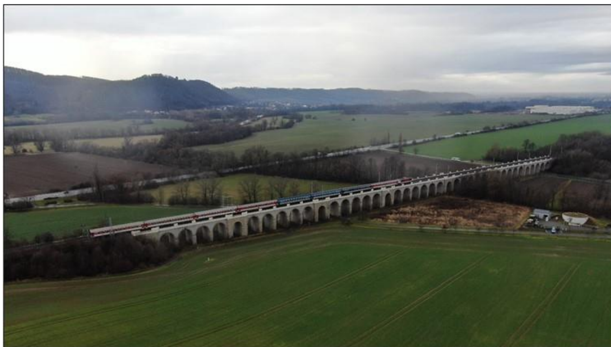
Obr. 32 Jezernický viadukt s dominantou hradu Helfštýn v pozadí
