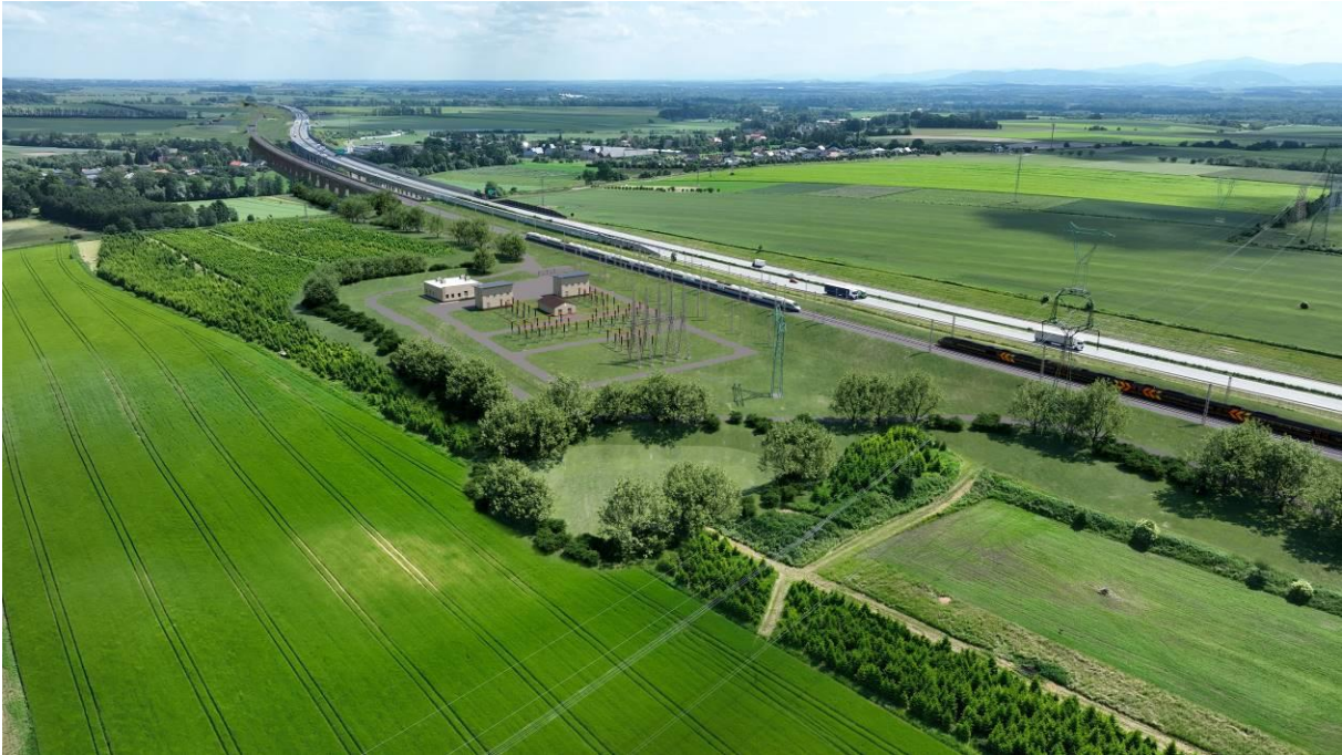
Obr. 112 Pohled na trať VRT, trakční měnárnu, dálnici D1
