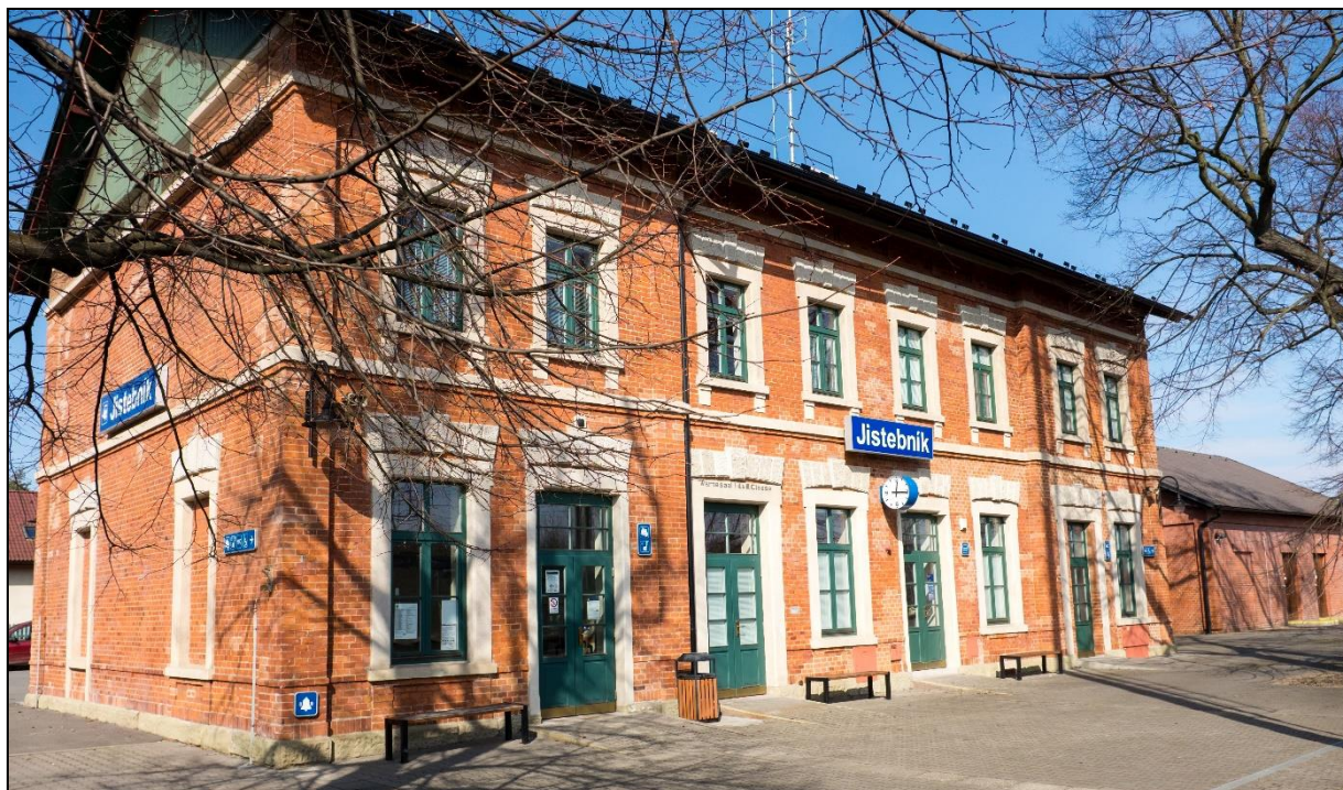
Obr. 103 Historická výpravní budova tzv. Ferdinandovy severní dráhy, Jistebník
