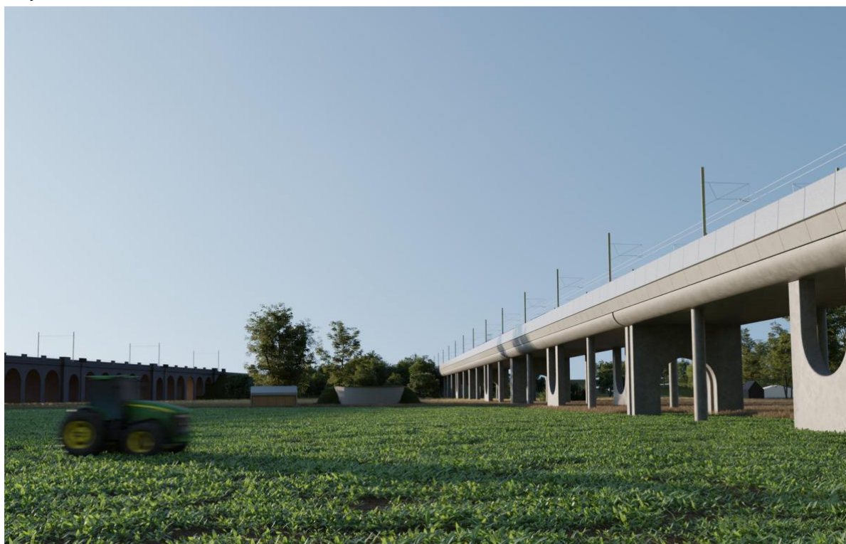
Obr. 109 Detail řešení nového Jezernického viaduktu – rozhraní mezi stávajícími viadukty a novým viaduktem VRT
