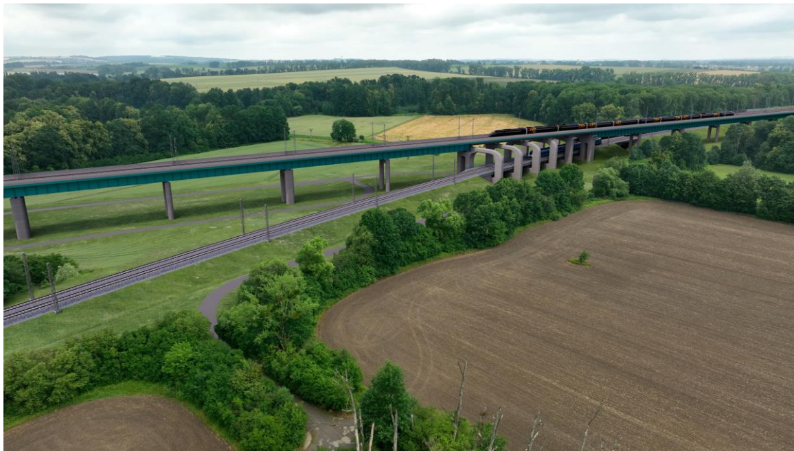
Obr. 114 pohled na estakádu trati VRT a její křížení přes stávající koridorovou železniční trať v oblasti vstupu do CHKO Poodří
