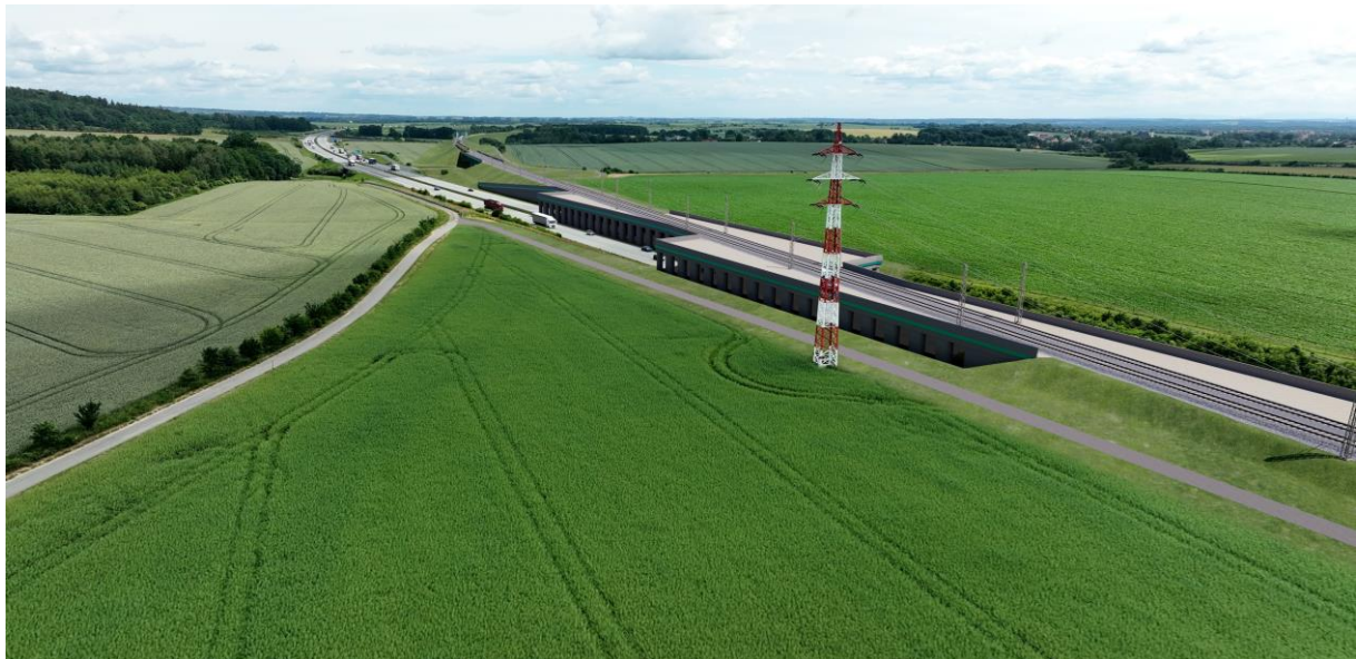
Obr. 113 Pohled na křížení trati VRT přes dálnici D1 tzv. galeriovým mostem v oblasti mezi Bílovem a Studénkou (vpravo zástavba Studénky)
