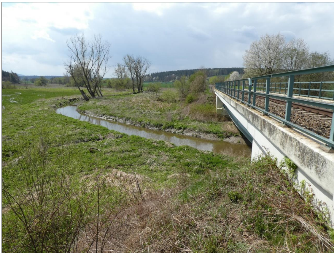
Obr.č.88 Stávající most přes Zubřinu
