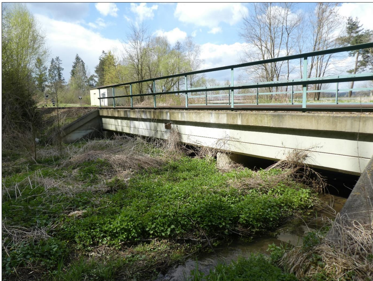
Obr.č.87 Stávající most přes Hlohovský potok
