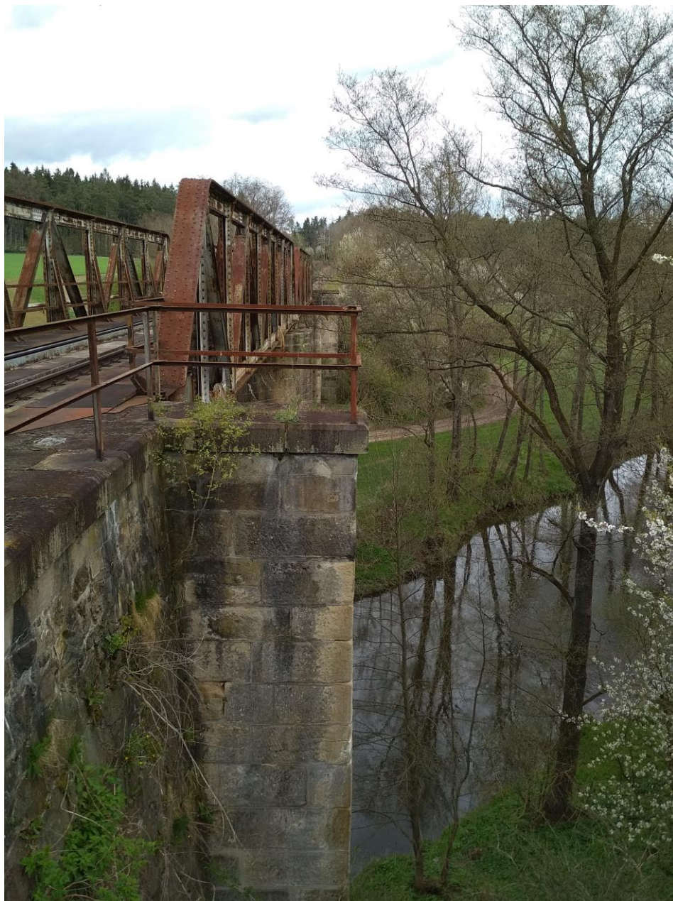
Obr.č.108 Pohled ze stávajícího mostu přes Radbuzu.
