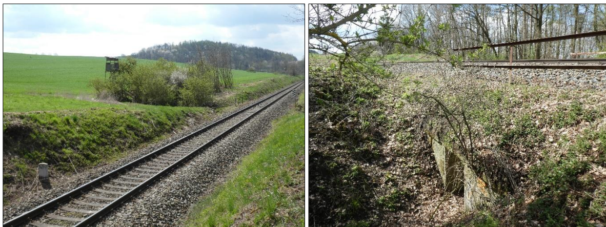
Obr.č.84 Charakter železnice, vpravo stávající propustek
