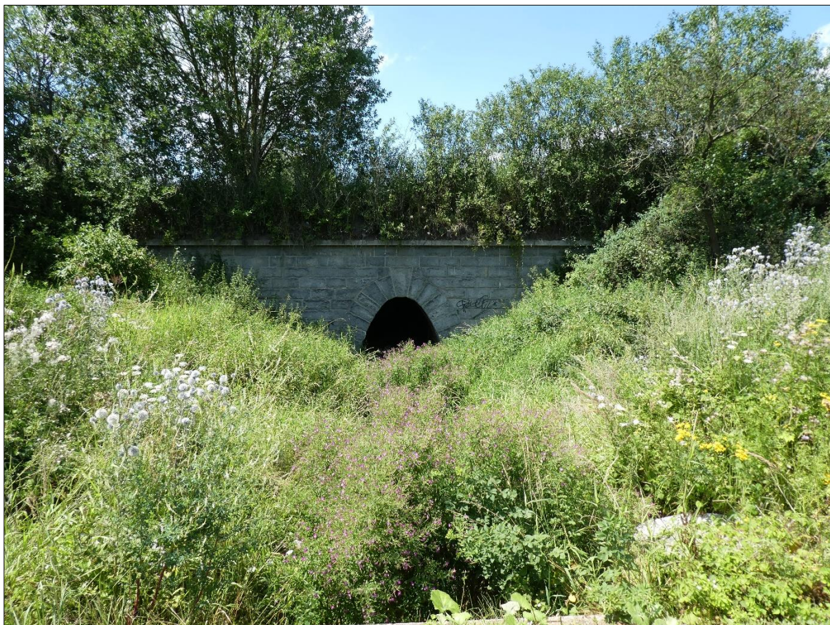
Obr.č.77 Stávající propustek
