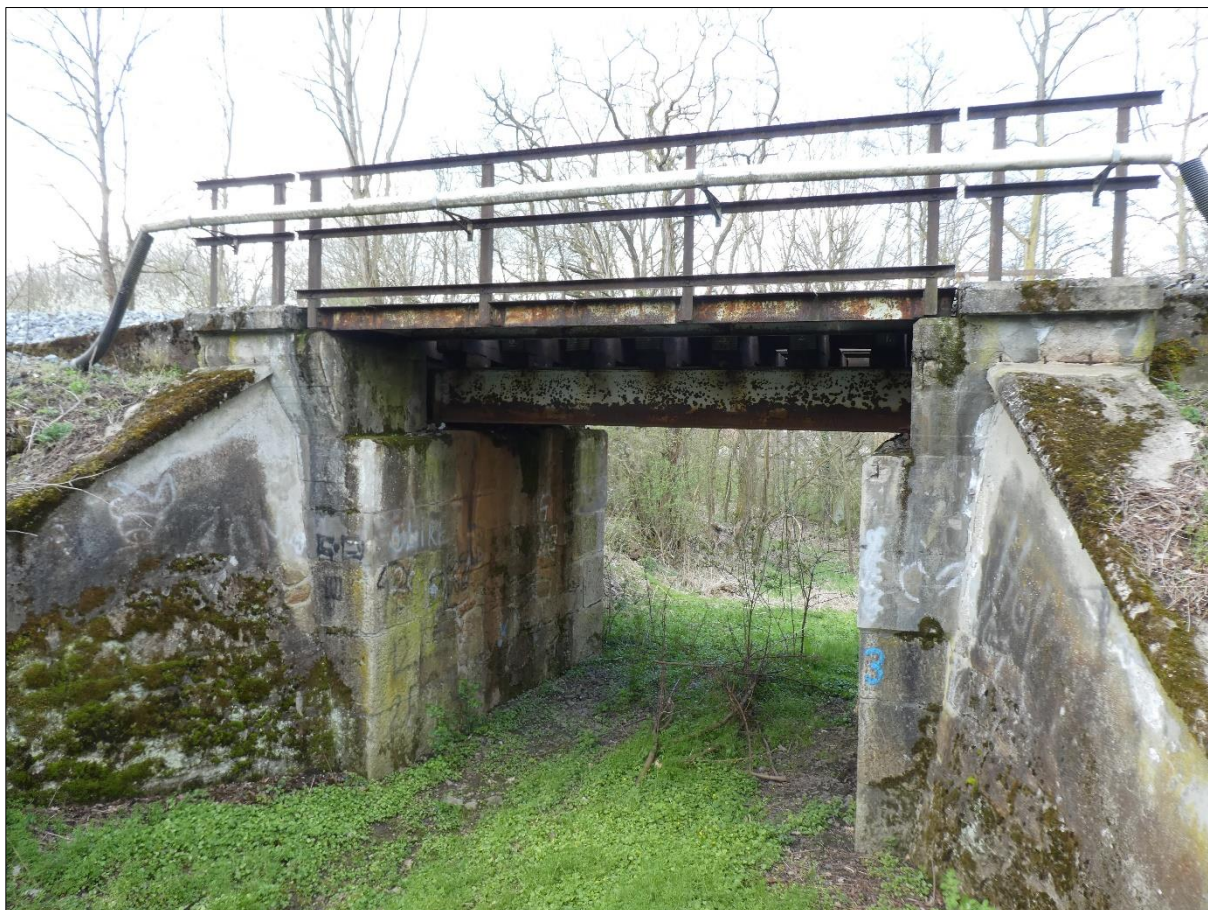
Obr.č.81 Současný, vyhovující stav mostu v km 146,084
