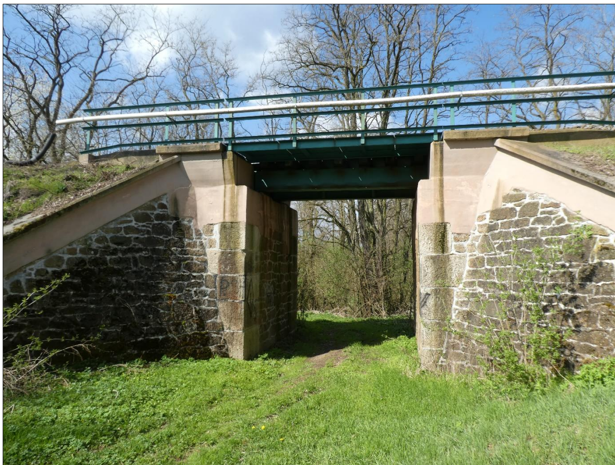
Obr.č.80 Současný stav mostního objektu s vyhovujícími parametry
