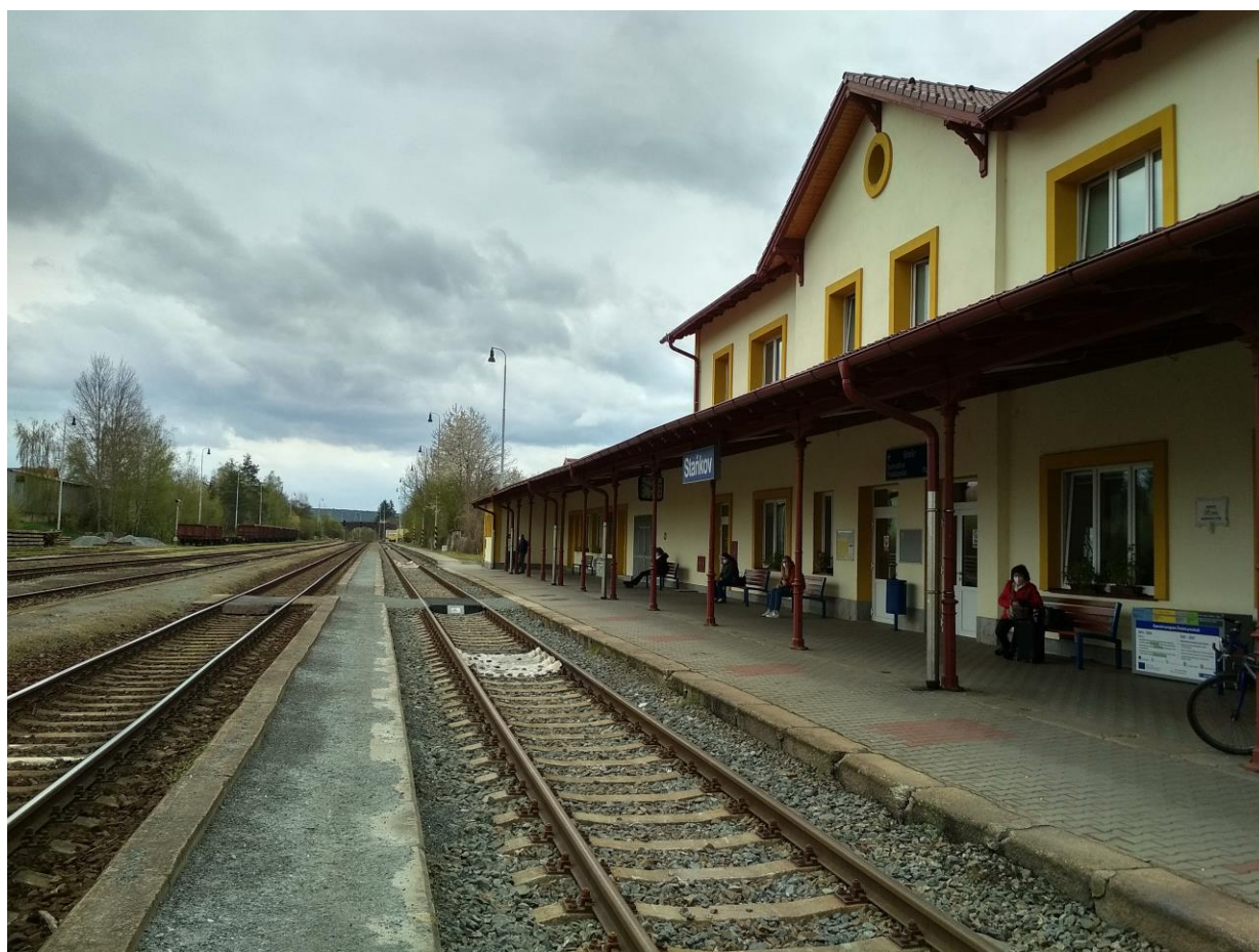
Obr.č.109 Pohled na žst. Staňkov.
