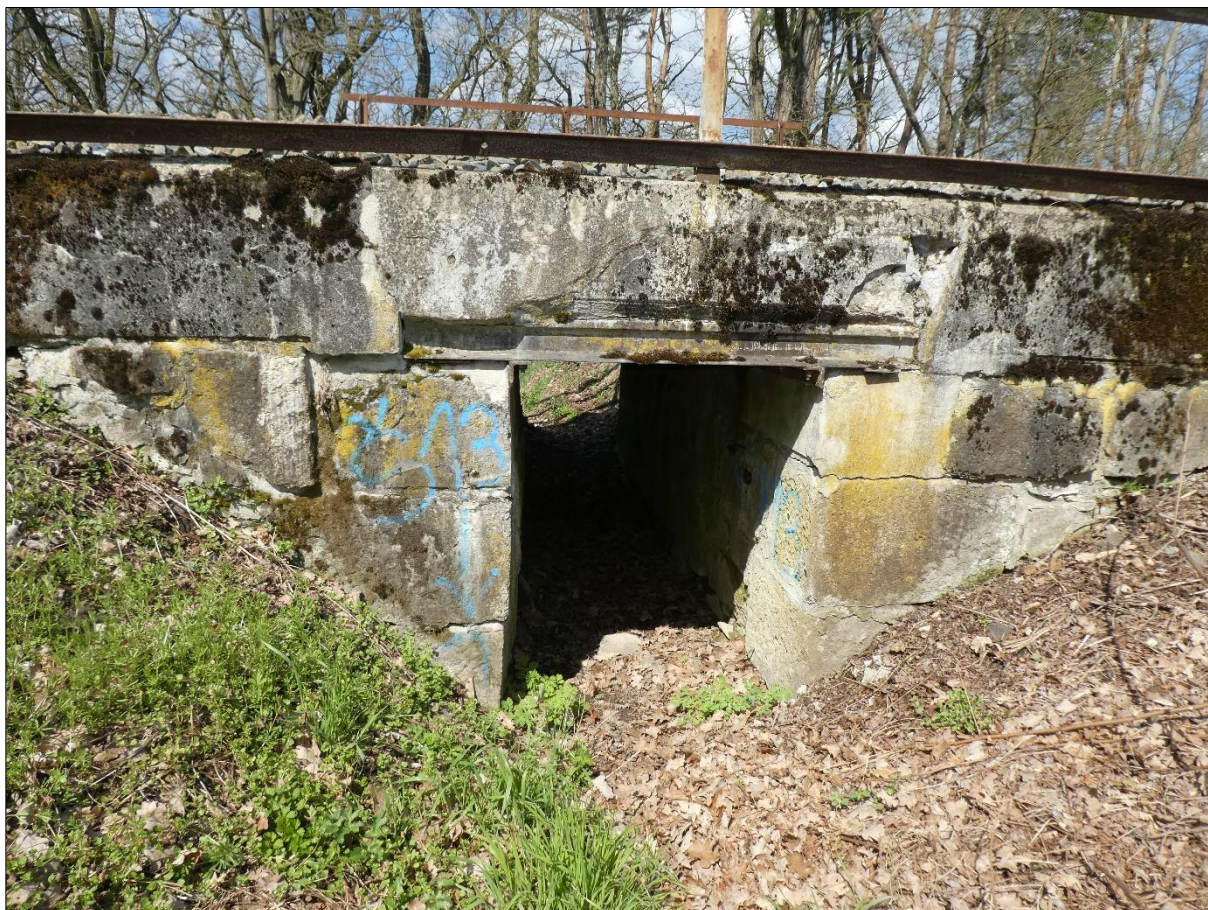
Obr.č.83 Pohled na stávající propustek
