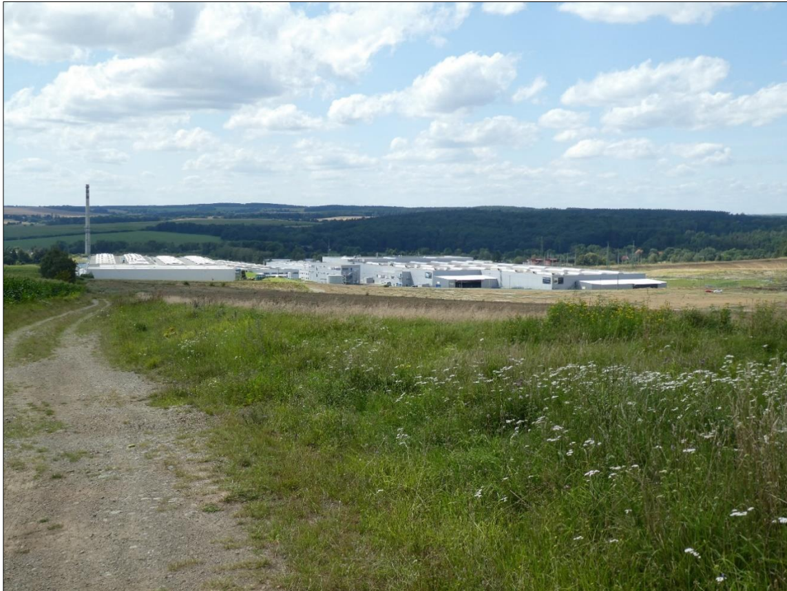
Obr.č.101 Rozsáhlý průmyslový areál v Holýšově
