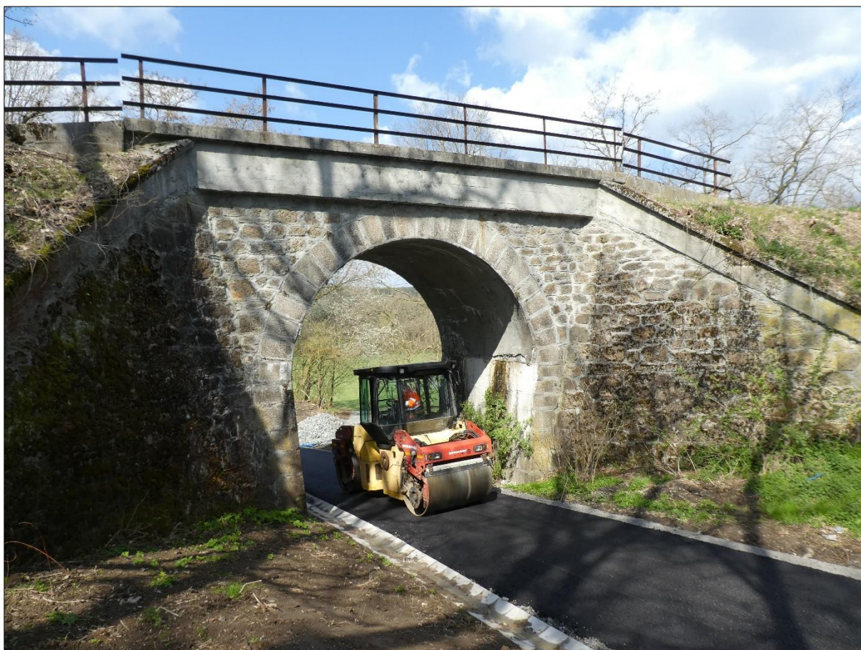
Obr.č.79 Současný stav mostu, resp. podmostí
