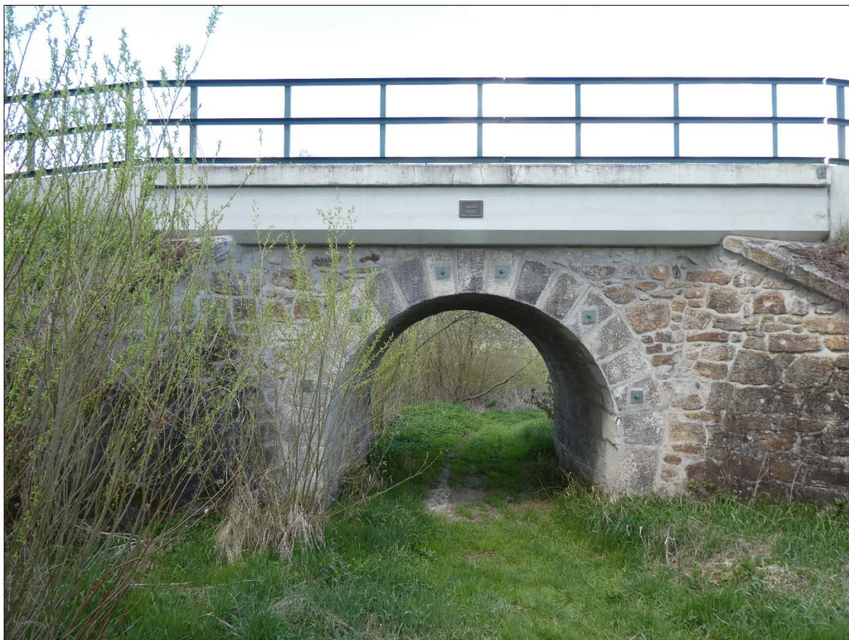
Obr.č.86 Současný stav mostu
