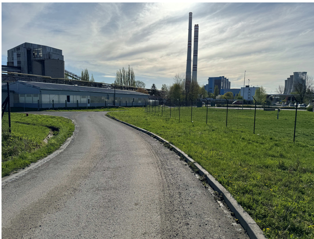
Příjezdová komunikace k místu plánované realizace záměru. Snímku dominují komíny EDĚ, vpravo jsou chladicí věže.
