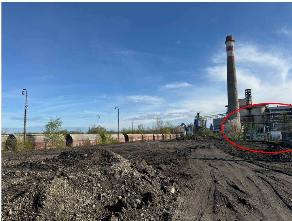
Pohled severním směrem. Snímku dominuje komín v areálu společnosti CEMEX. Vpravo je patrný potrubní most, na kterém budou situována potrubí napojující posuzovaný záměr (vyznačen barevně)
