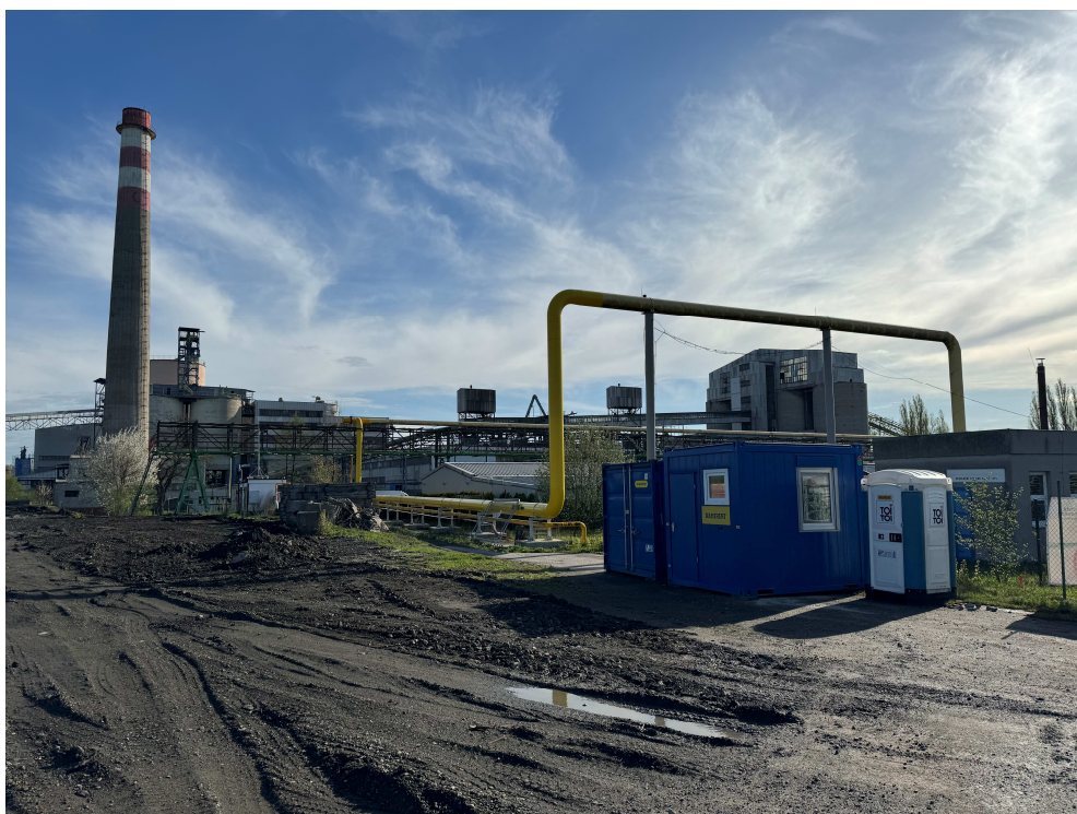
Sousedící areál společnosti CEMEX. Snímku dominuje potrubí zemního plynu (žluté; „omega“) a potrubní most, na kterém budou umístěna potrubí pro posuzovaný záměr
