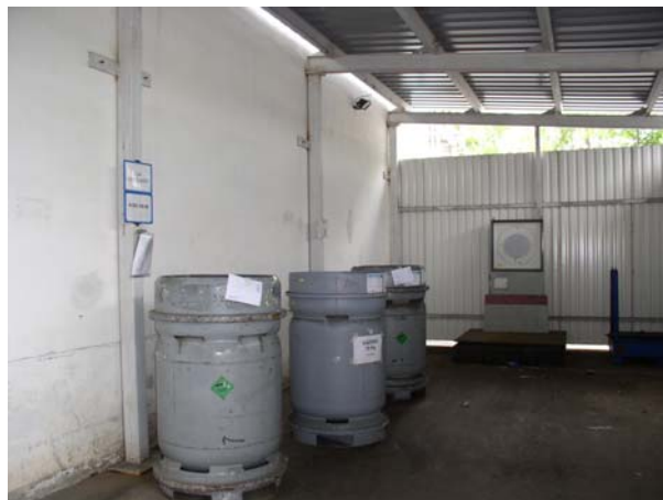
Obrázek 6: Interiér stávajícího skladu - zásobníky chladicích kapalin
