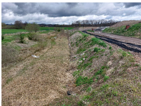
Foto 11: prostor výstavby 4.etapy na západě
