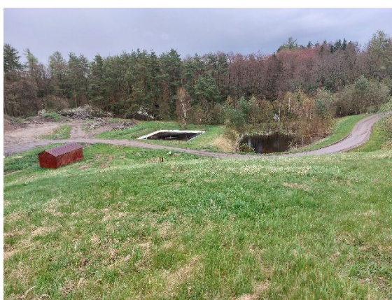
Foto 16: Sběrná jímka průsakových vod a retenční nádrž
