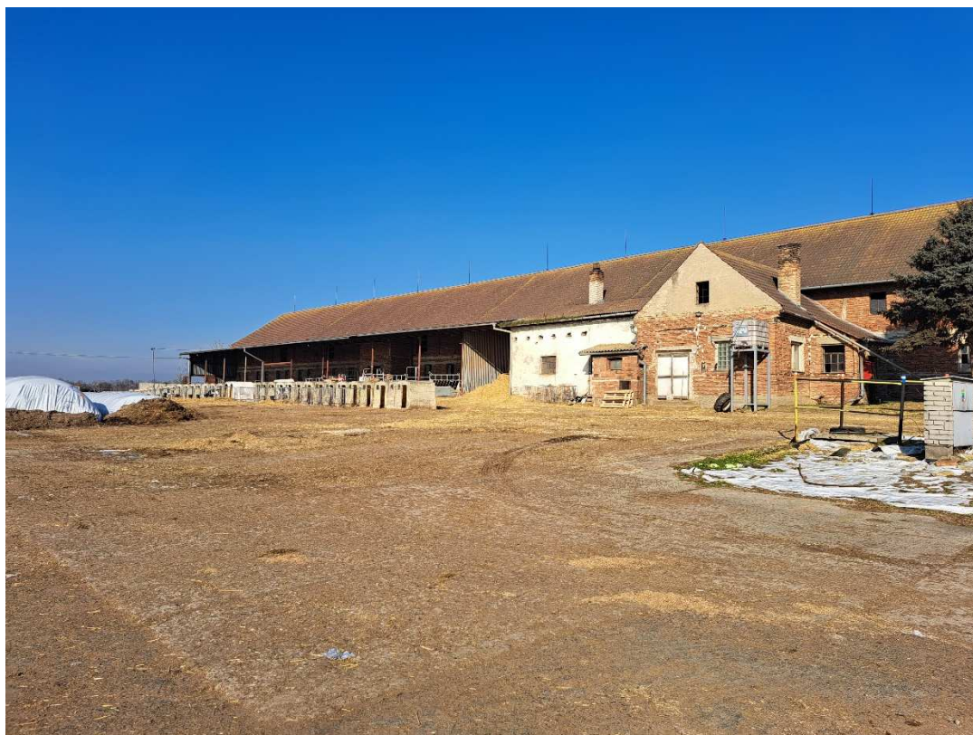
Pohled na stáj k modernizaci (porodna, krávy na sucho, telata)
