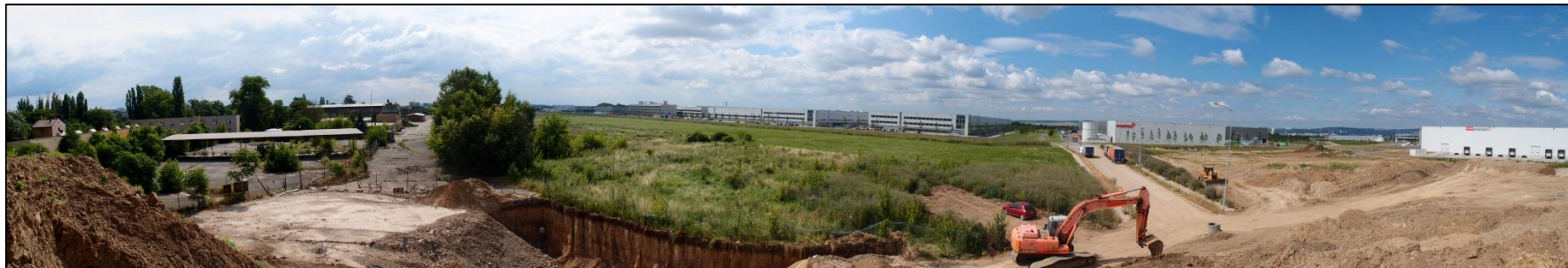
Obr. 8 Panoramatický snímek lokality záměru, vlevo opuštěný zdevastovaný areál bývalého vojenského letiště, vpravo volná zatravněná plocha (foceno z navezené haldy severně od zájmové lokality)
