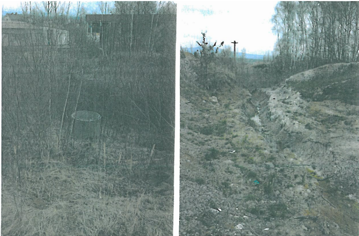
Obrázek č. 3: Monitorovací studna, drenážní rýha
