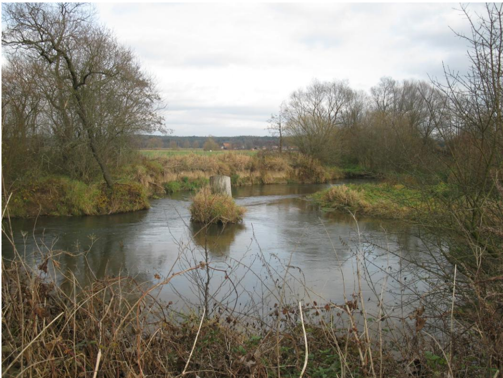
Obr. 1: Místo výstavby MVE Plchovice (pozice plánované strojovny – pravý břeh za pařezem)
