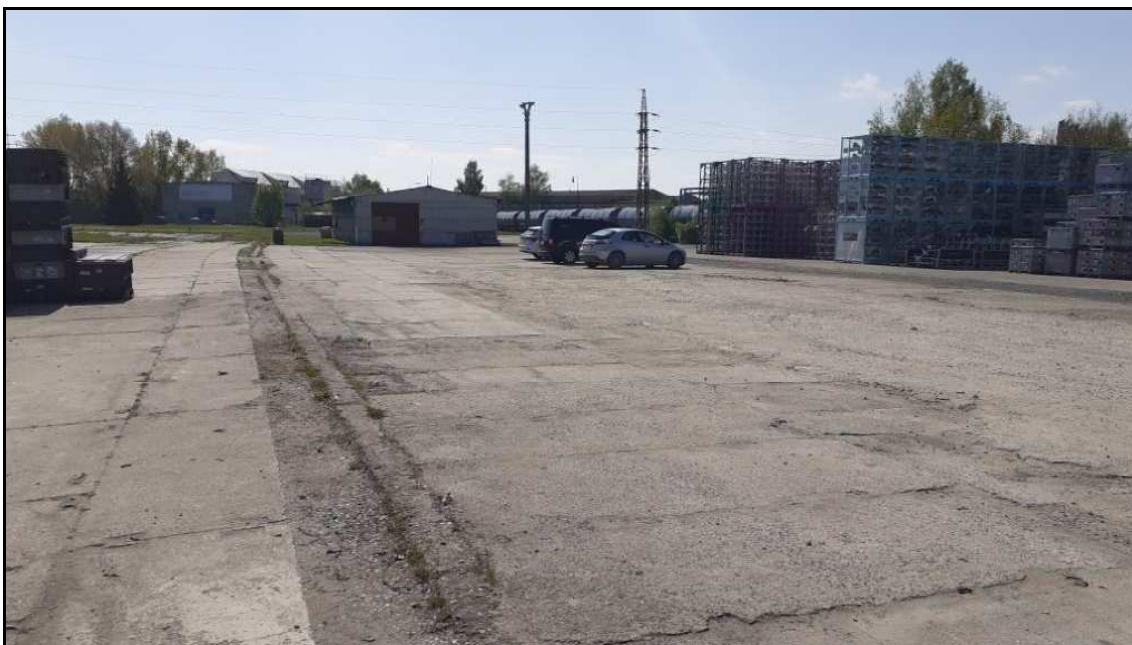
Obr. 5: Pohled na pozemek pro výstavbu terminálu a betonárny (foto autor)
