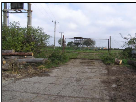
Severní hranice areálu se stávajícím trafem
