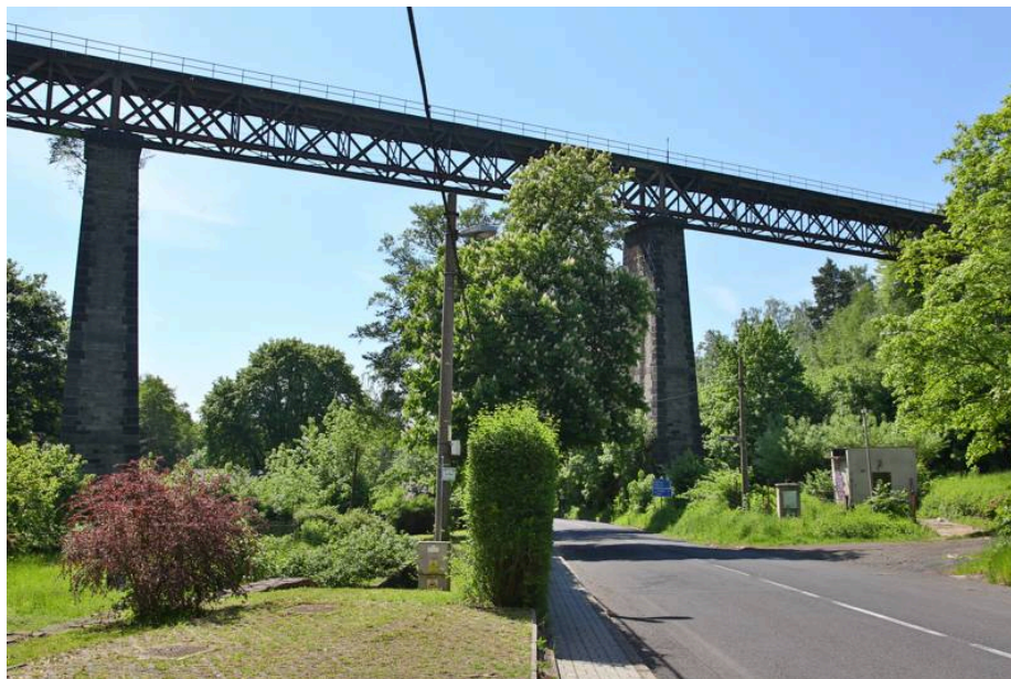
Obr. 15 – železniční most v obci Hrob, části Mlýny
