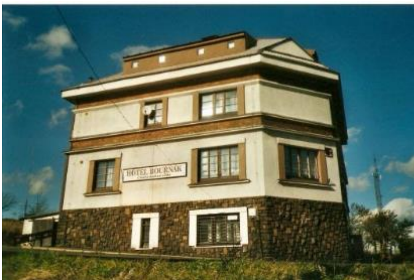
Obr. 14 Chata na Bouřňáku, zdroj: moldava.cz 8/2022
