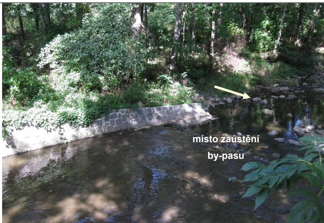
Obr. 4: jez nad Vilémovem - pohled na zpevněné podjezí
