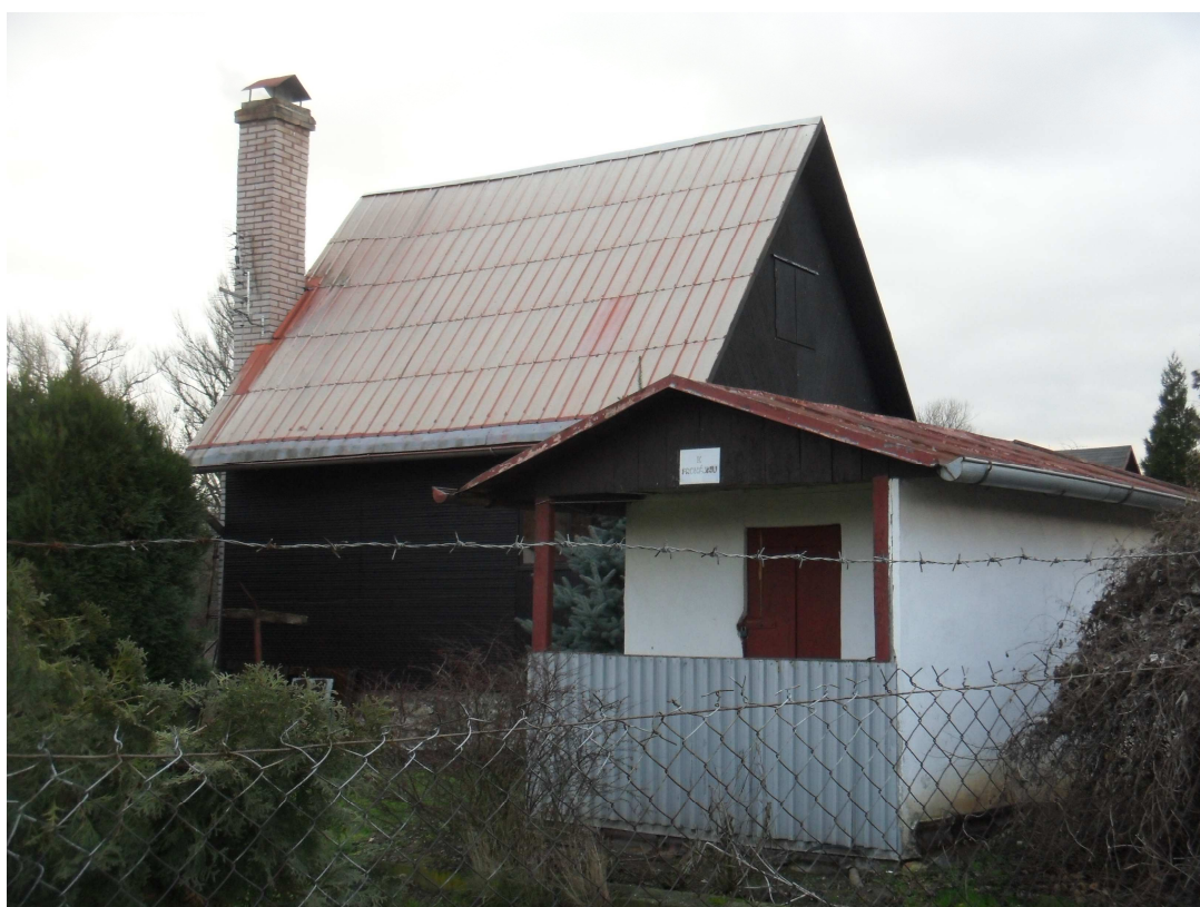
Chata určené k demolici
