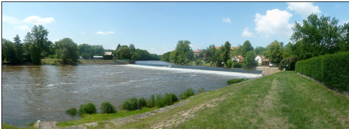
Obr. č. 8: Pohled na hostěnický jez z levého břehu (místo výstavby plánované MVE na protějším břehu)
