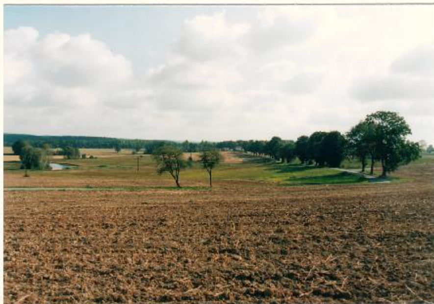
Foto č. 13 : Průchod tělesa komunikace v km 1,25 přes ornou půdu a podmáčenou louku s rybníčkem
