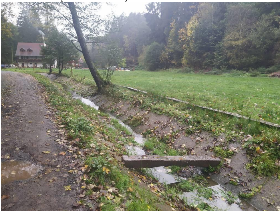
Foto 11: Pohled na plochu P.21 západním směrem a regulované koryto Jetřichovické Bělé, do kterého navržená plocha P.21 zasahuje.
