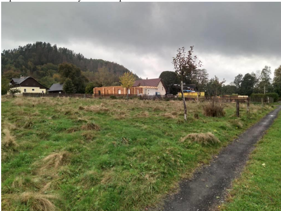
Foto 1: Probíhající výstavba obytných objektů v rámci plochy P.06 a charakter navazujících nepravidelně udržovaných lučních porostů.
