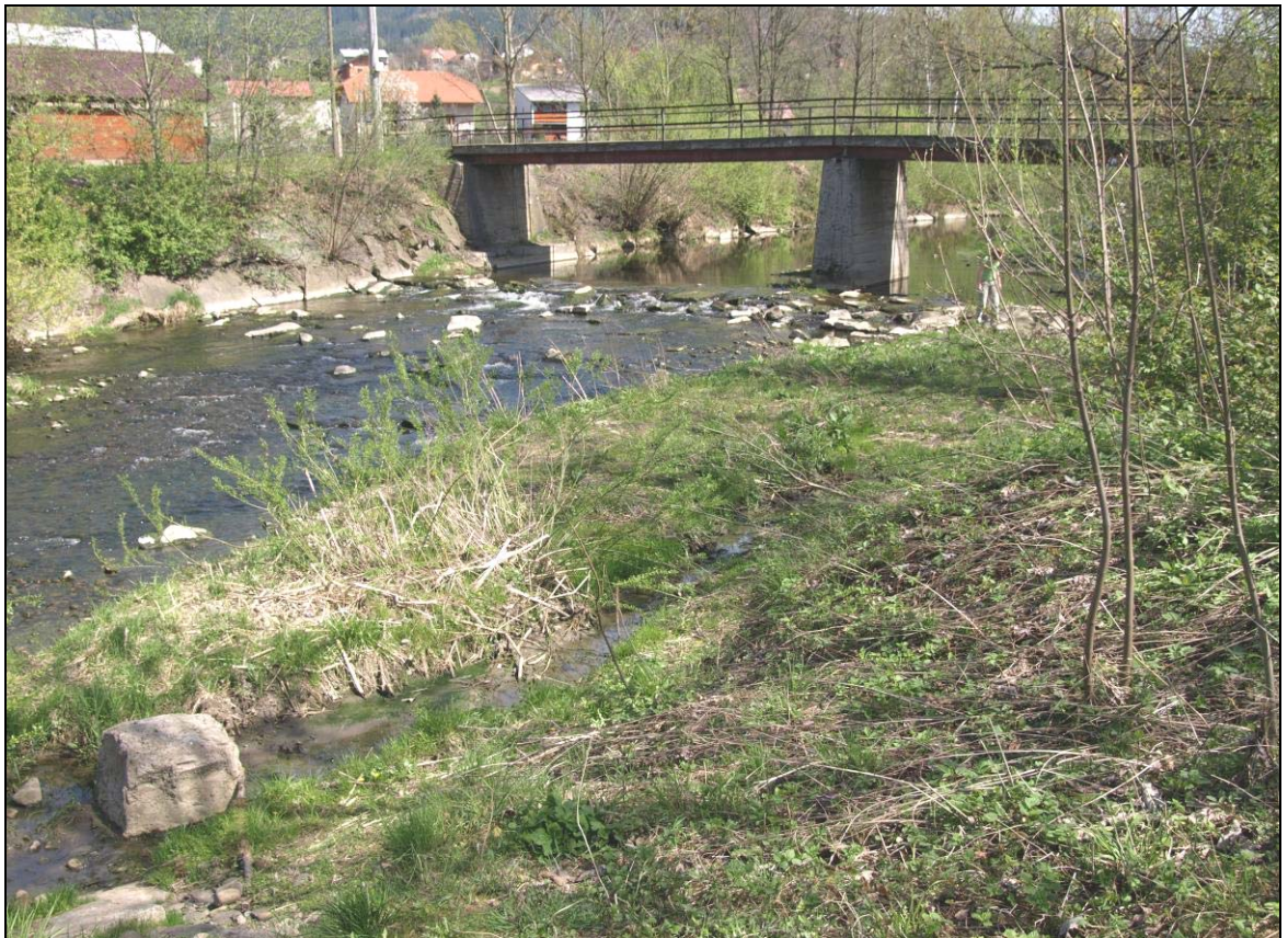
Obr. 6.: Místo vyústění z ČOV "Pod Javořím" do Olše. Zarostlý štěrkový náplav, při obvodu lemovaný kanalizační stokou. Na náplavu převládají nitrofilní, ruderalní a invazní druhy rostlin.
