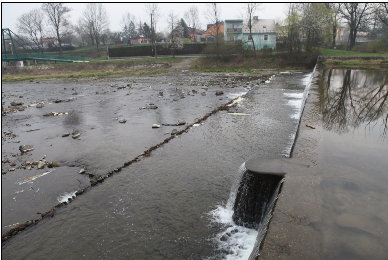
Pohled k východu na spádový stupeň v ř. km 25,650, 05. 04. 2014 (RK)
