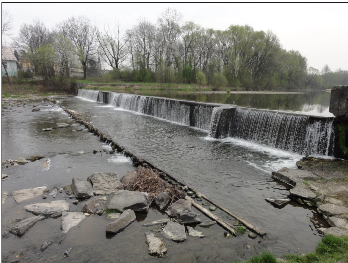
Stávající jezový objekt na řece Ostravici určený k rekonstrukci, foto 5.4.2014 (TK)
