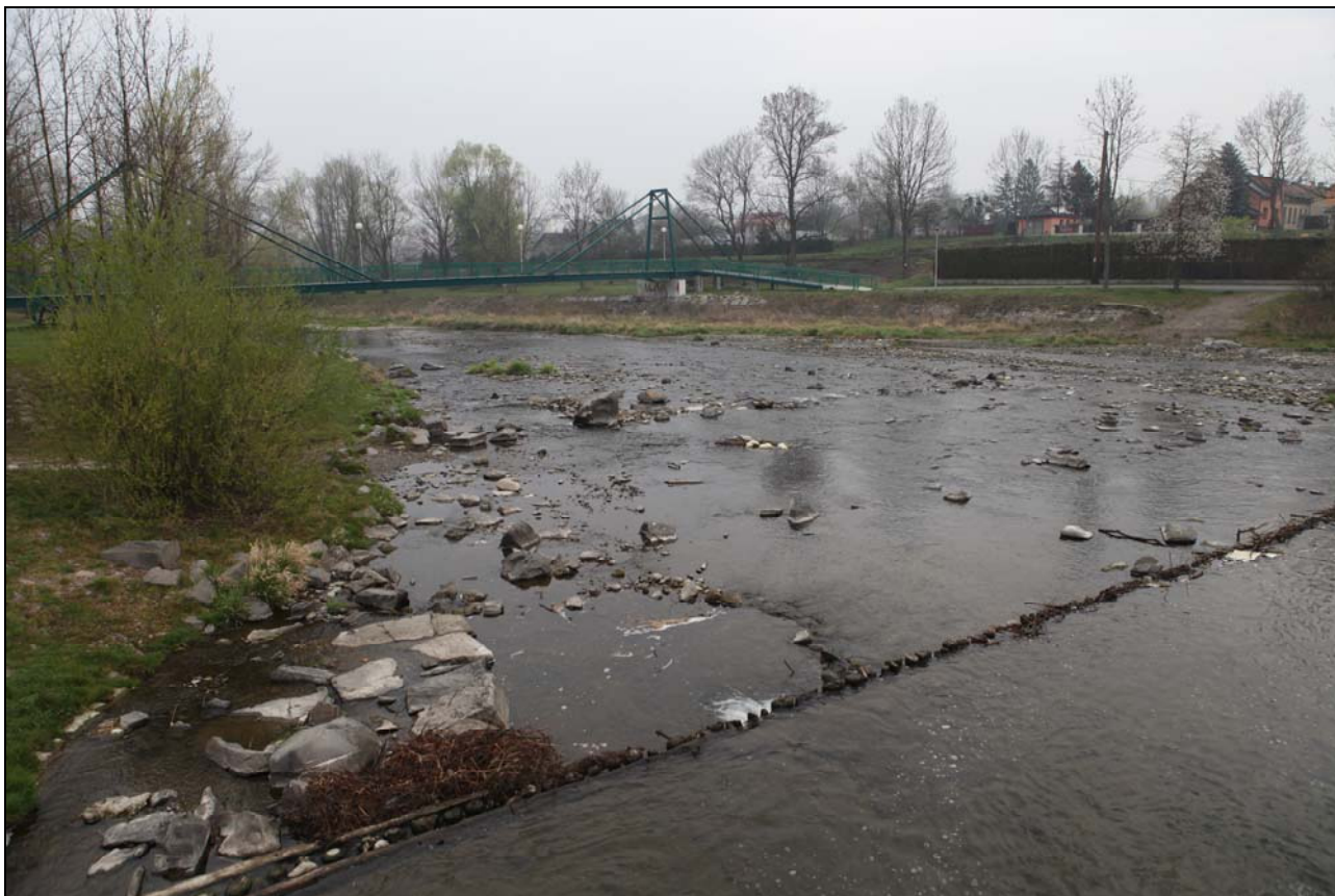
Řeka Ostravice pod vývarem stávajícího jezu.
