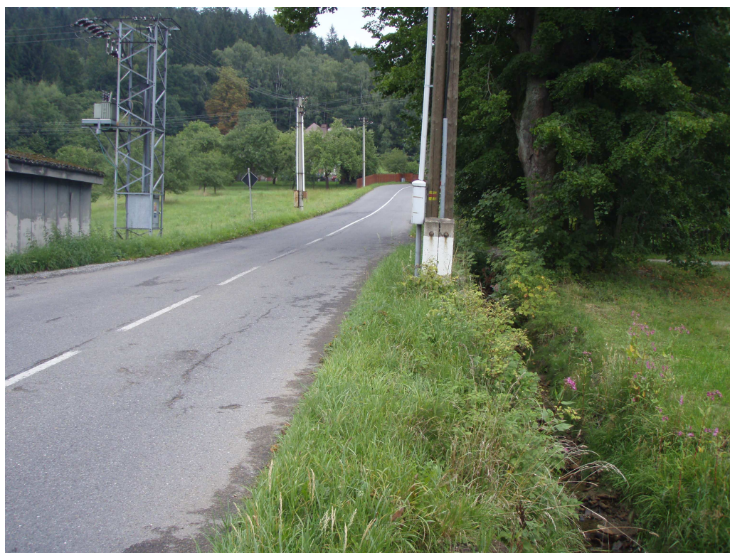
Foto č. 2: Drenáž podél komunikace, která ústí do kanalizace vedoucí do toku Olše
