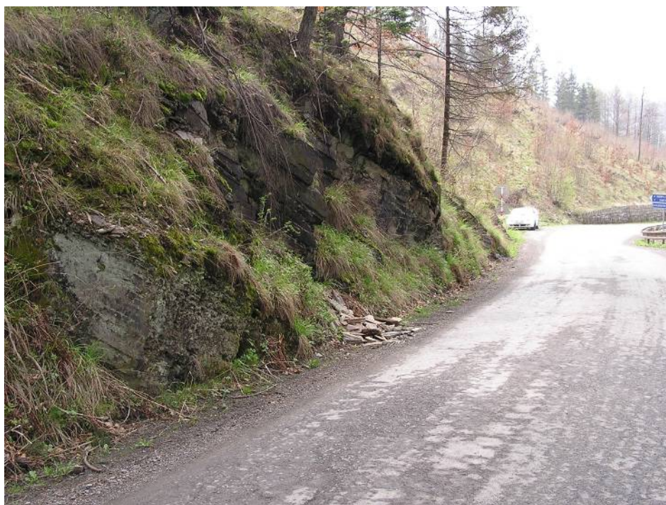
Obr. 9.: Pohled na část skalního svahu určeného k sanaci.
