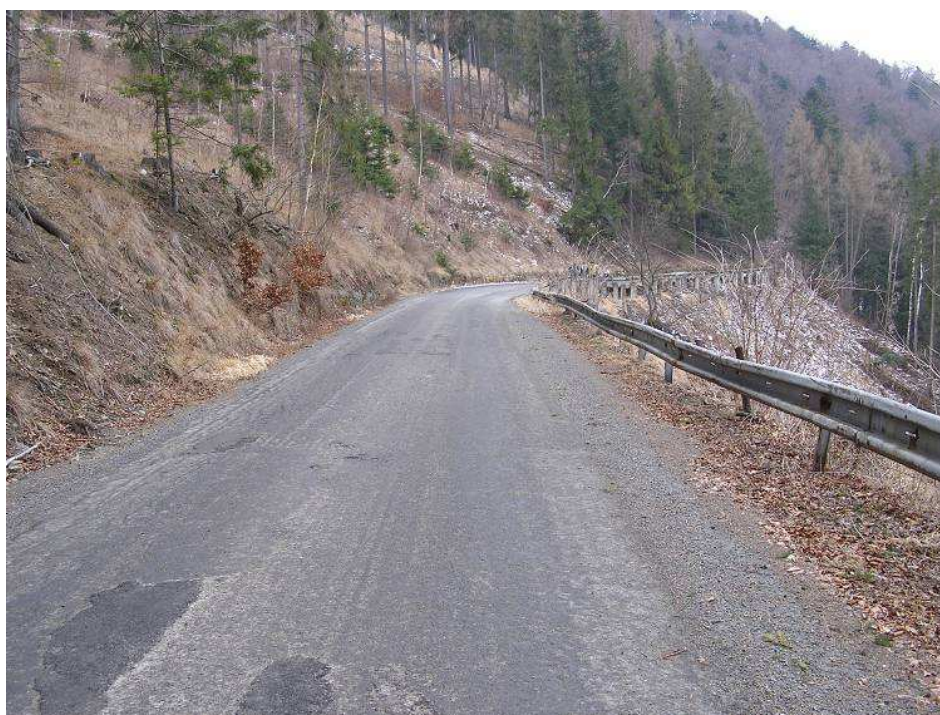
Obr. 2.: Začátek trasy řešených úprav silnice. Levý strmý svah bude zajištěn zárubní zdí z gabionů ve svahu vpravo bude provedena opěrná monolitická zeď.
