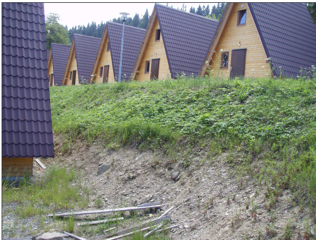
Charakter obnaženého svahu terasy pro dokončení stabilizace
