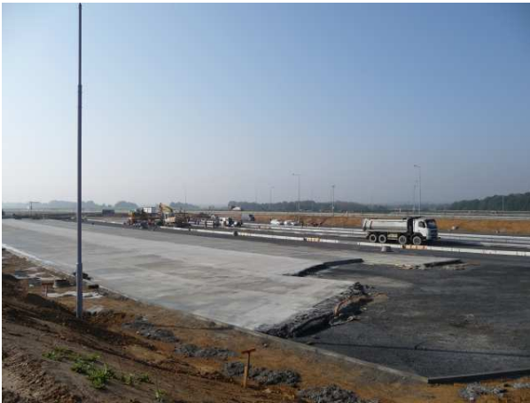
Obrázek 3: Plocha pravé strany oboustranné dálniční odpočívky ve fázi asfaltování. Vjezd možný z trasy Brno - Ostrava
