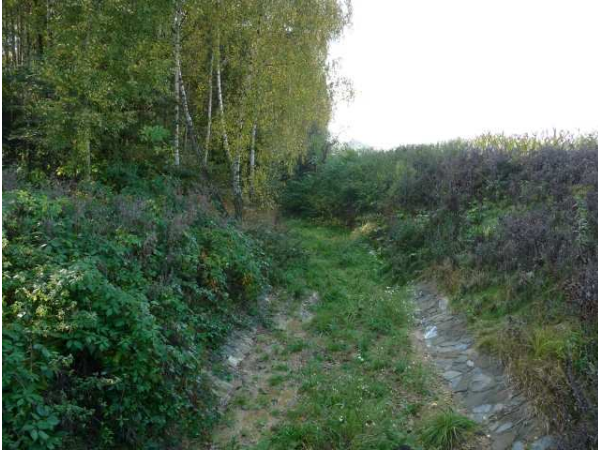
Obrázek 7: Vyústění melioračních vod do upraveného koryta z přilehlých zemědělských ploch na okraji lesního porostu.
