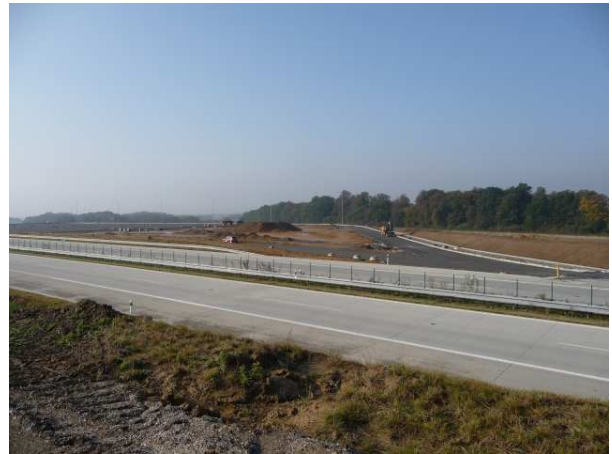
Obrázek 4: Plocha levé strany oboustranné dálniční odpočívky ve fázi asfaltování. Vjezd možný z trasy Ostrava - Brno
