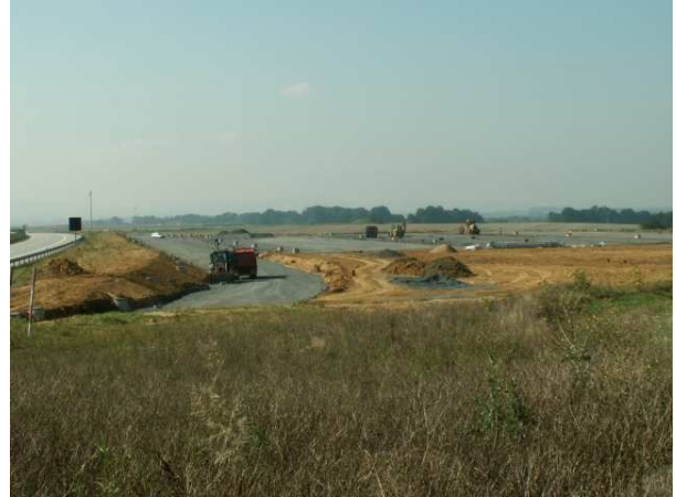
Obrázek 2: Plocha levé strany oboustranné dálniční odpočívky ve výstavbě. Vjezd možný z trasy Ostrava - Brno
