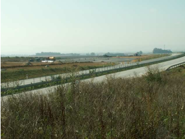
Obrázek 1: Plocha pravé strany oboustranné dálniční odpočívky ve výstavbě. Vjezd možný z trasy Brno - Ostrava
