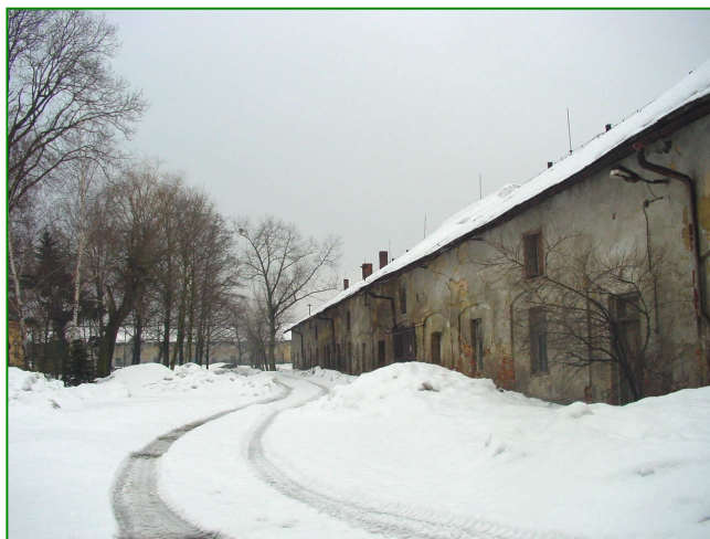
Objekt na jehož místě bude realizován kravín
