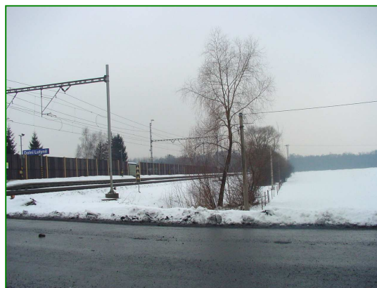
Pohled na protihlukovou stěnu odčleňující zástavbu části Nerad
