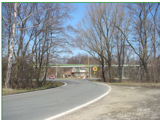
Pohled od ulice U Skleníků (směr jihozápad)
