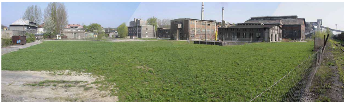
Obrázek č. 6: Současný stav areálu – pohled od jihu.
