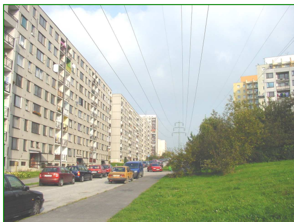
Ulice Emmy Destinové, vedení VVN, VN
