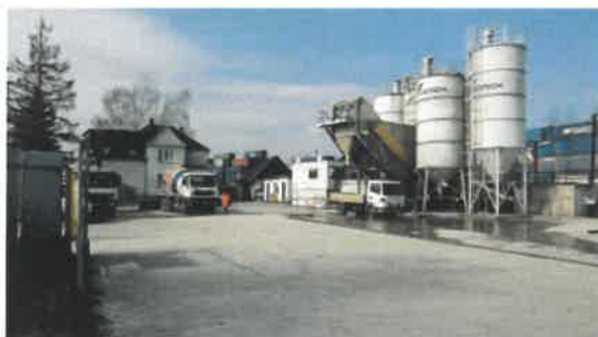
Pohled na stávající prostor betonárny (areál)
