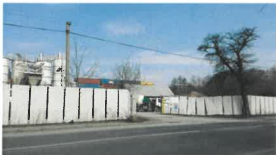
Pohled na stávající prostor betonárny (vjezd)
