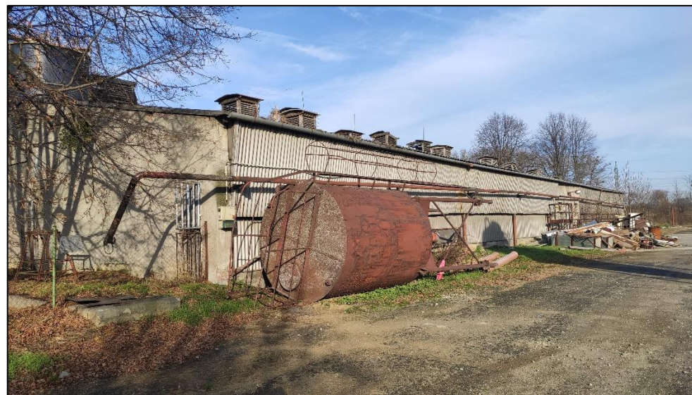
Obr.4: Místo stavby ze od jihu.
