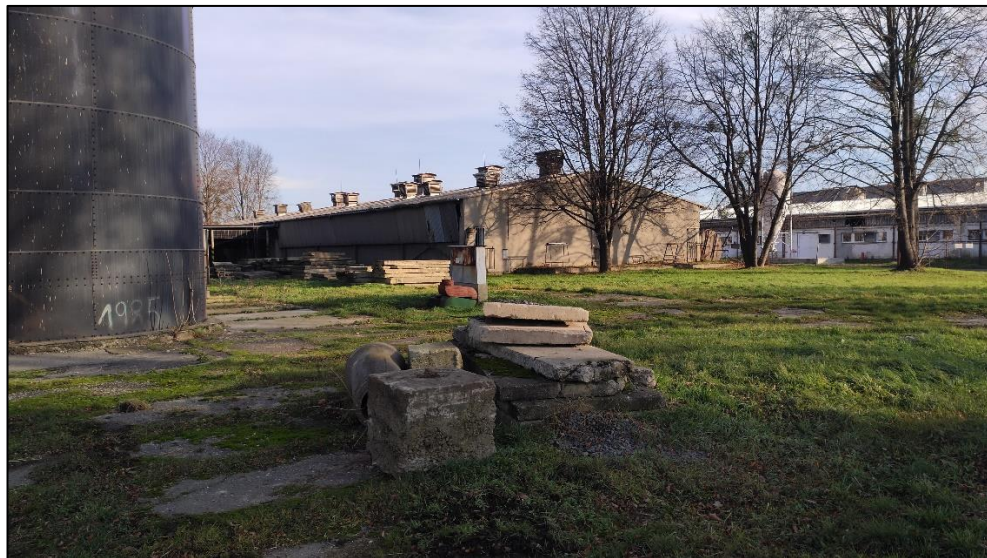
Obr.1: Místo stavby od západu.
