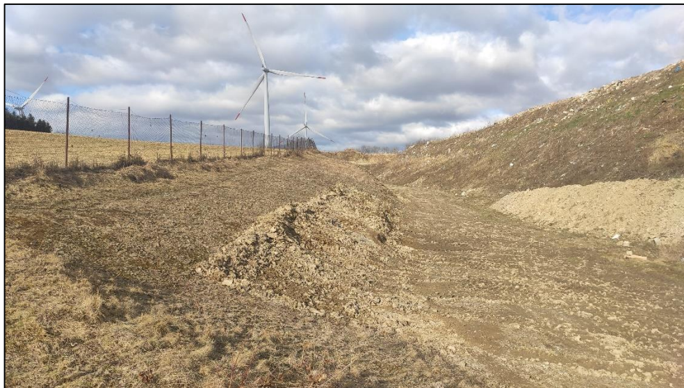
Obr.1: Pohled na místo stavby od východu. Skládka bude rozšířena na trvalý travní porost v levé části fotografie.
