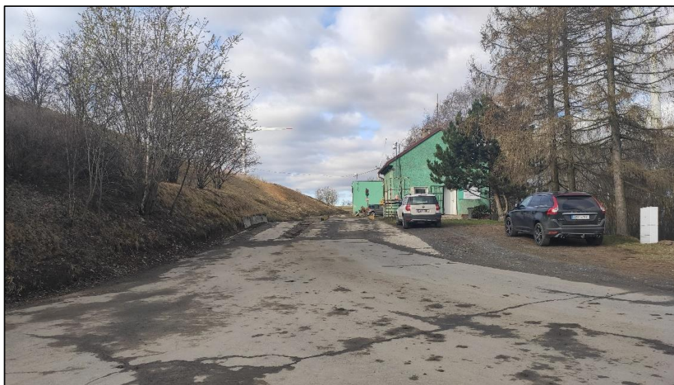
Obr.3: Stávající provozní budova a příjem odpadů.
