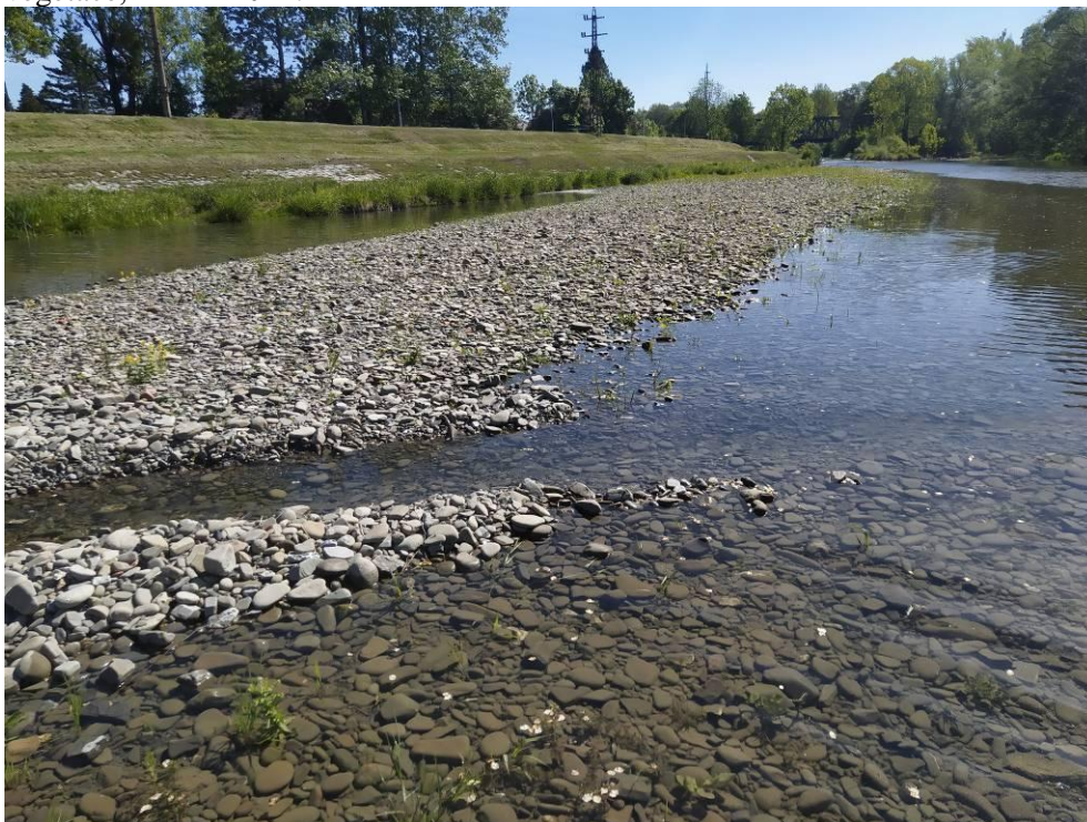
Obr. 14: Štěrková lavice (segment B) výše toku od stávajícího stupně Riviéra, prakticky bez vegetace, květen 2022.
