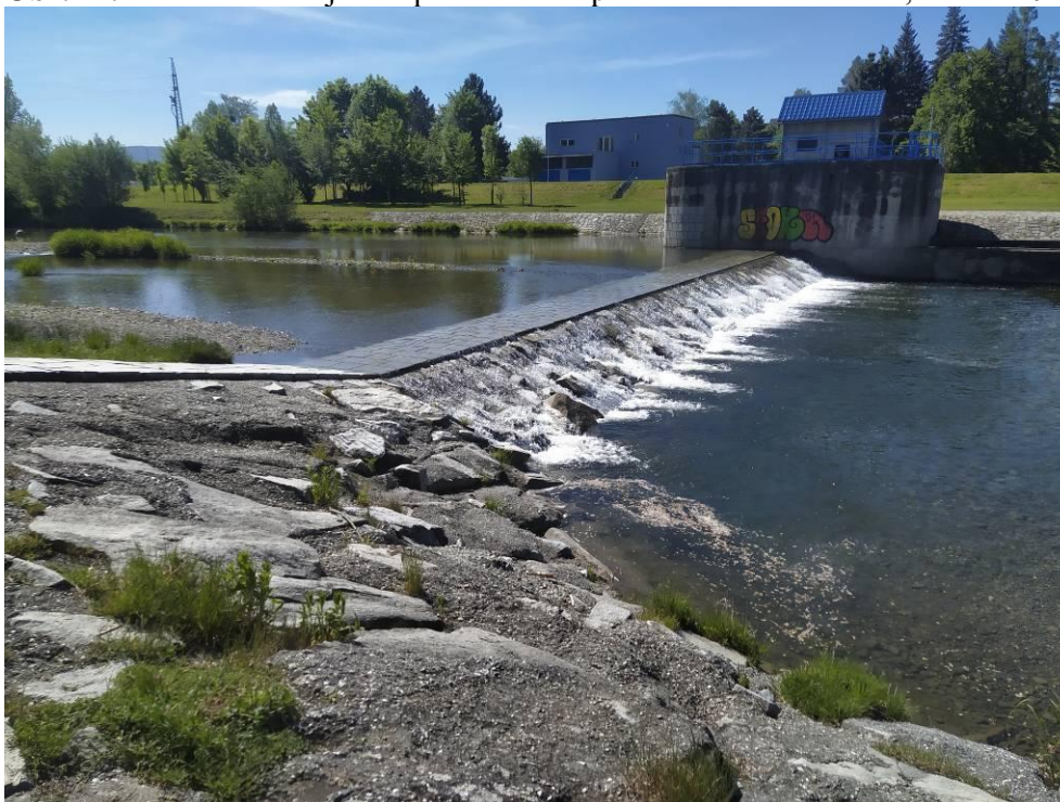
Obř. 12: Pohled na stávající stupeň Riviéra z pravého břehu Ostravice, květen 2022.
