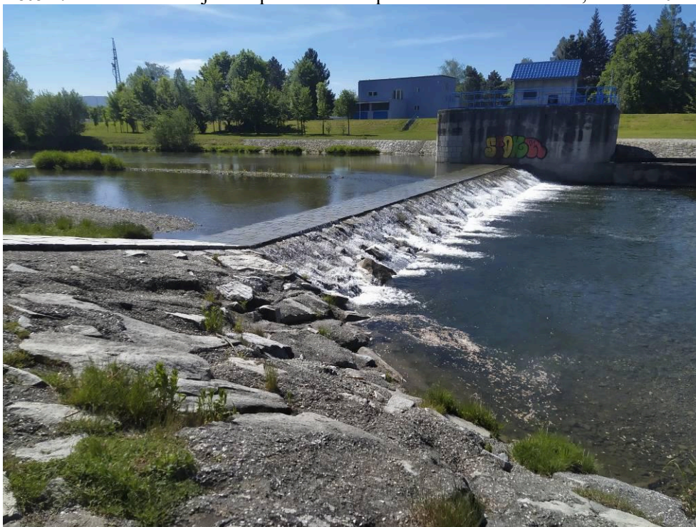
Foto 4: Pohled na stávající stupeň Riviéra z pravého břehu Ostravice, květen 2022.
