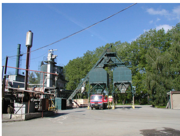
pohled na obalovnu, vlevo kotelna ohřevu živice
