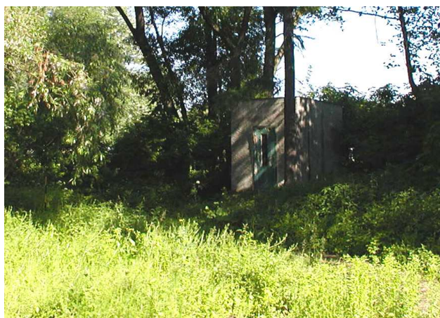
objekt vodárny u studny
