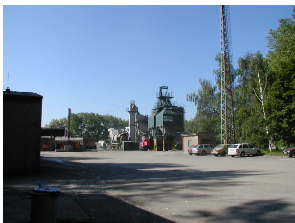
pohled na obalovnu, před obalovnou rozvodna a stožár osvětlení (budou v rámci realizace záměru odstraněny)
