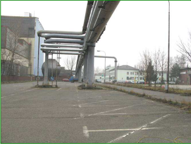
Venkovní zpevněná plocha (parkoviště)
