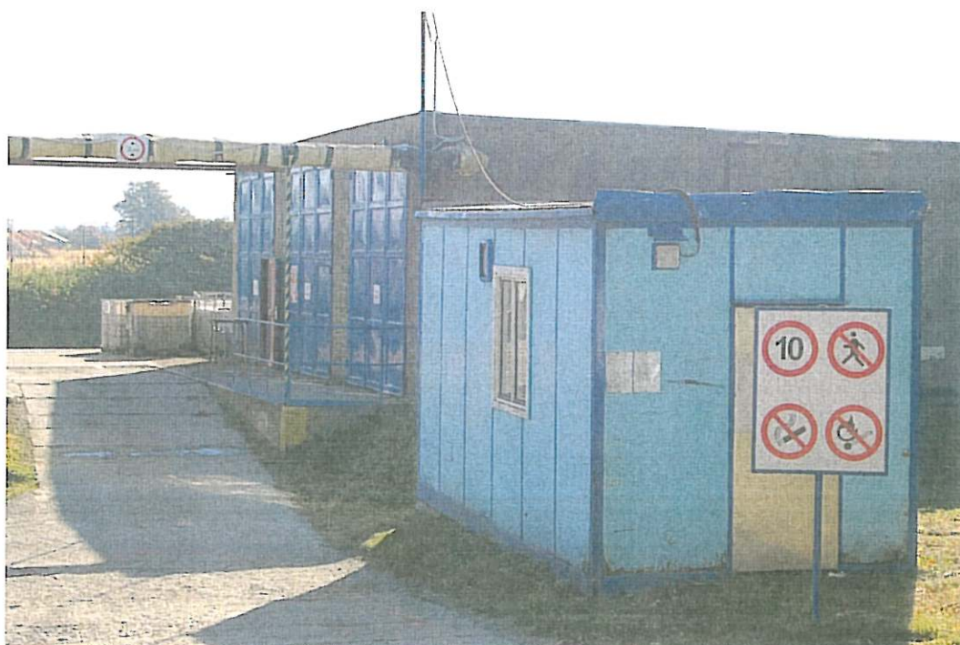
Foto 2: Pohled na sklad (umístěn uprostřed), dále dílna a manipulační plocha
