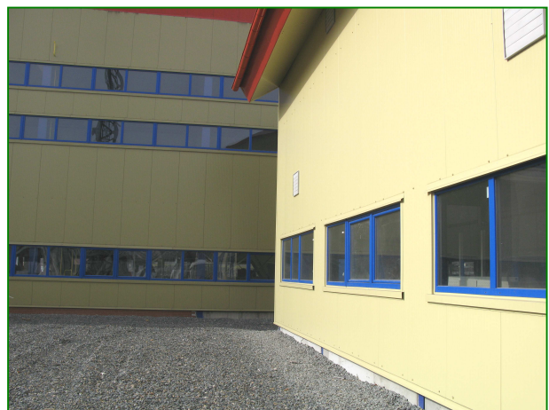
Vpravo hala pro finální úpravu výrobků, přímo stávající kompletační hala
