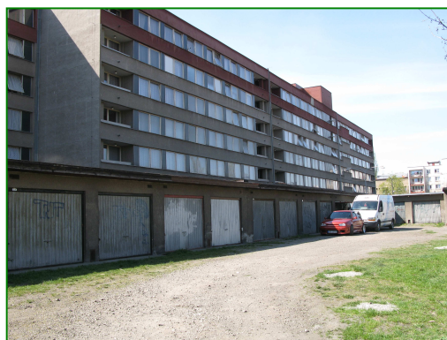
Garáže, za nimi 13-ti patrový panelový dům
