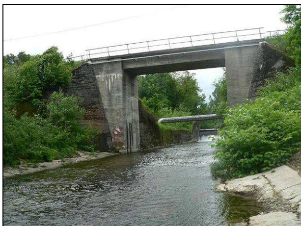
Obr. 22: Stávající stav mostu v km 120,230
