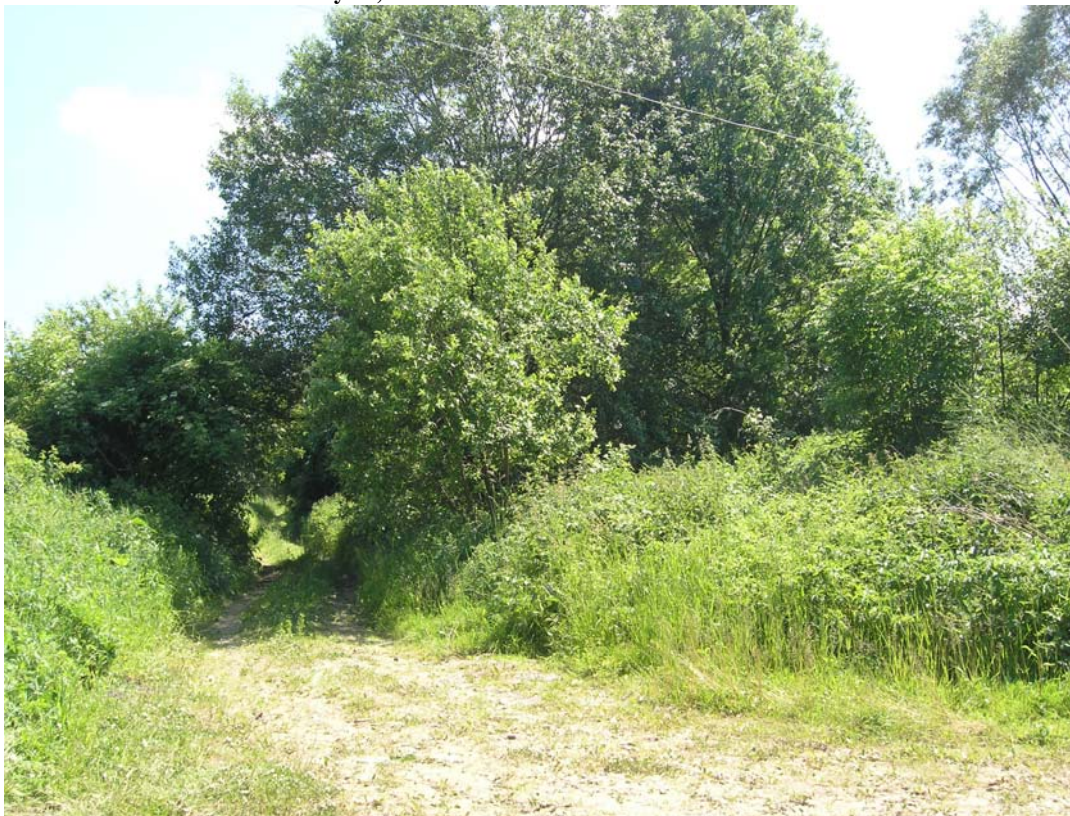
Obrázek 2: Pohled na km stavby 56,940
