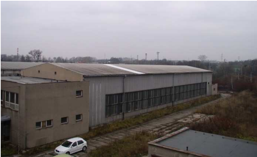
Obr. č. 1 - Pohled na objekty SO1 - výrobní haly, SO2 - administrativní přístavek a SO3 - kotelna
