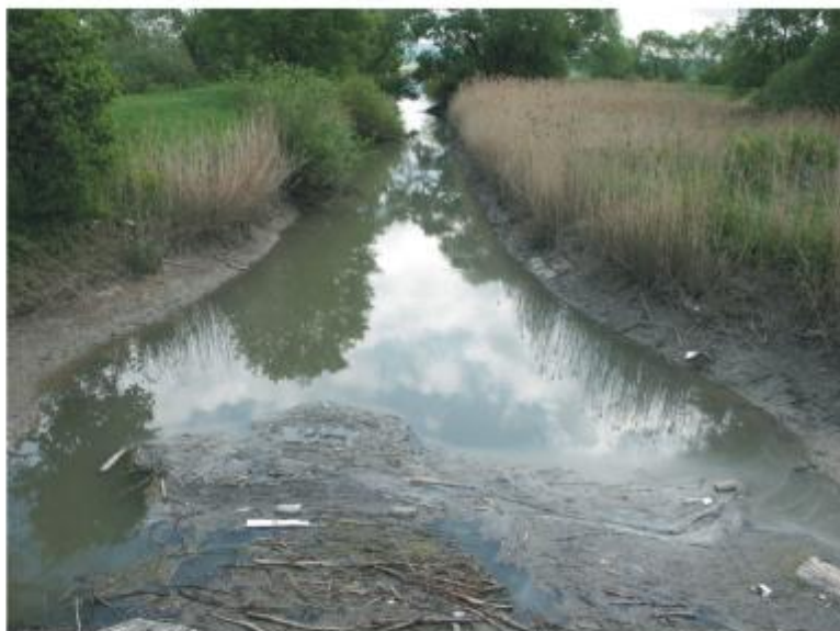
Pohled do prostoru nad stávajícím jezem v době průzkumu byla hladina uměle snížena z důvodu provádění prací v toku nad jezem
