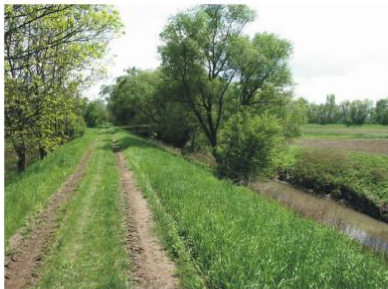
Pohled na plavební kanál a souběžnou polní cestu v jv. směru (střední část řešeného úseku - v pozadí hospodářský most v km 0,670)
