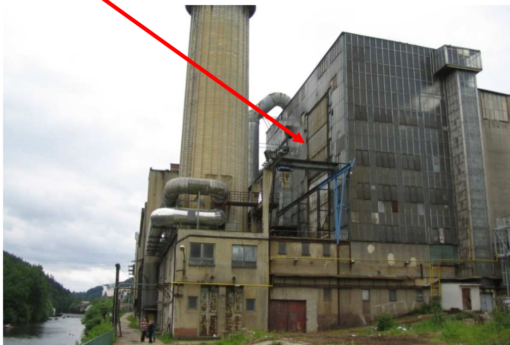
Pohled ze severní strany na budovu kotelny
