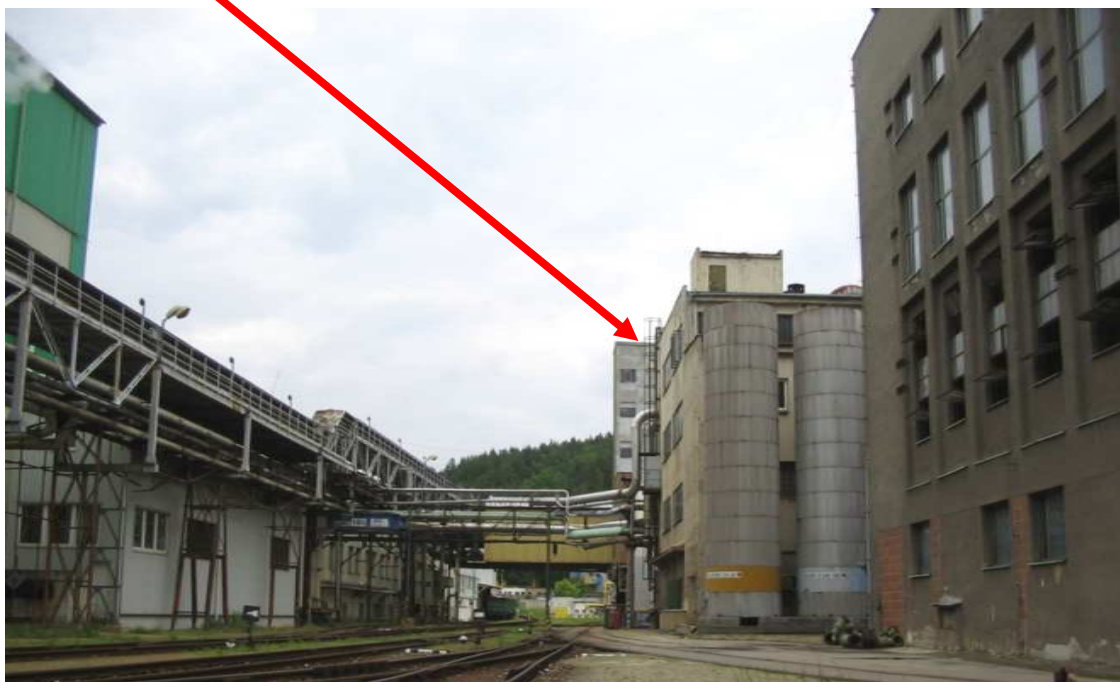
Pohled z jižní strany závodu na budovu kotelny
