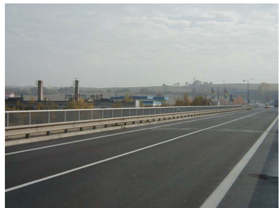
11. Stávající mostní těleso bude zachováno pro doprovodnou komunikaci (pohled od Z)
