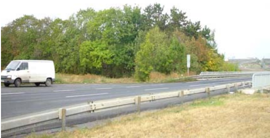
8. Jediné místo, kde dojde k zásahu do vzrostlých dřevin – stromový lem údolí Smolnického potoka (pohled od J)
