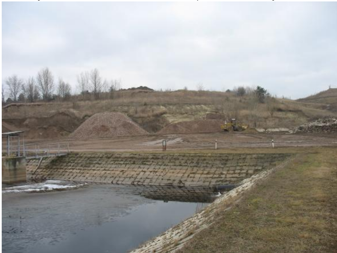
Snímek 3 – Pohled na plochu III. a části IV. etapy skládky přes jímku průsakových vod a plochu pro recyklaci stavebních sutí a skládku stavebních odpadů a stavebních recyklátů
