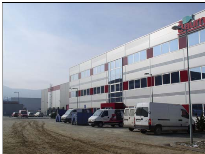
Obrázek H.9: Hala H2 – současný stav
