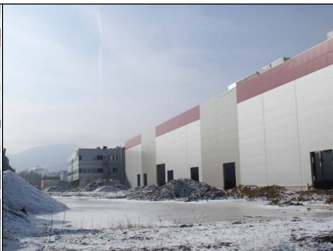
Obrázek H.10: Přístavba skladové části
