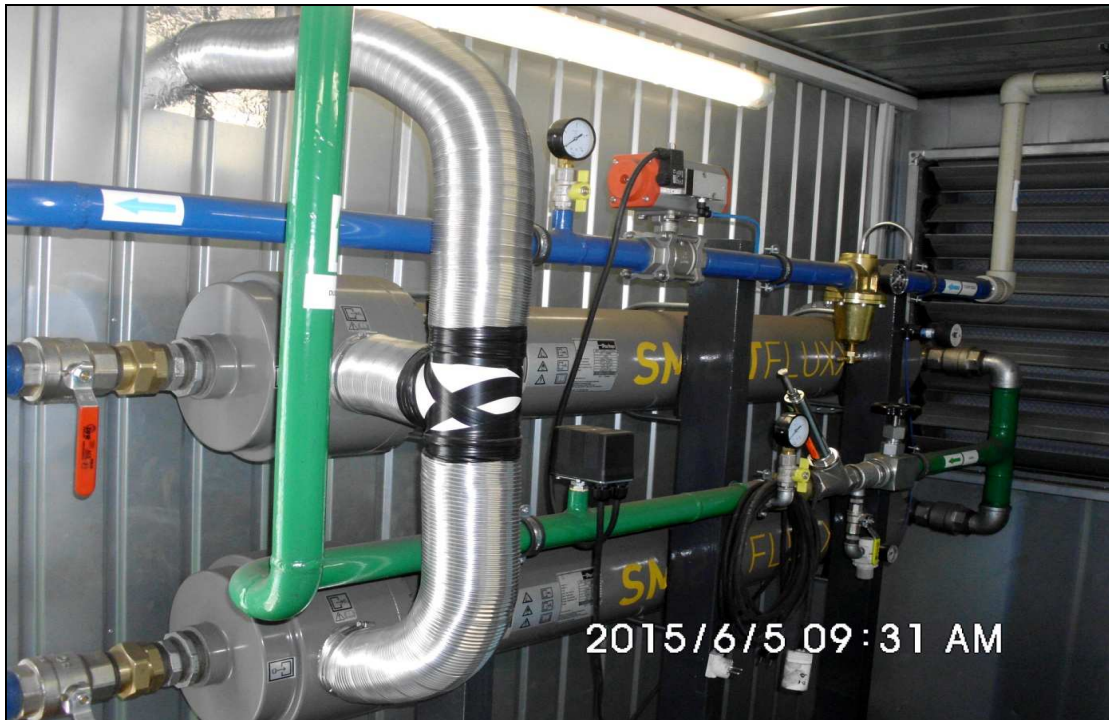
Obr. 1. Membránový modul ze svazku dutých vláken, ve kterých dochází k samotnému oddělování kyslíku a dusíku. Modré potrubí (nahore) – přívod vzduchu, zelené potrubí (dole) odvod vyrobeného dusíku.
