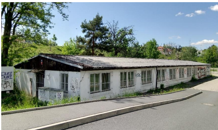
pohled východní od trati
