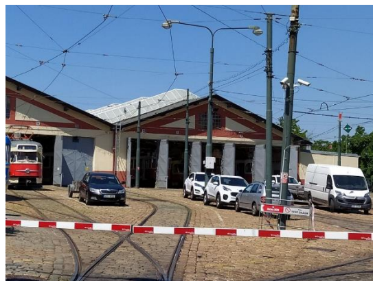
Pohled na garáže vozovny
