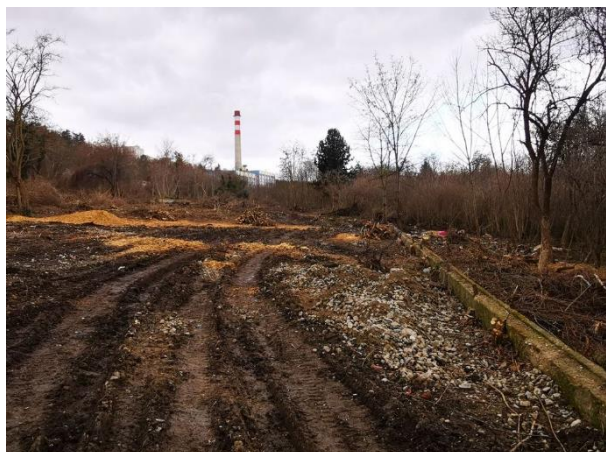
Pohled z ulice Na Rozdílu směrem na JZ
